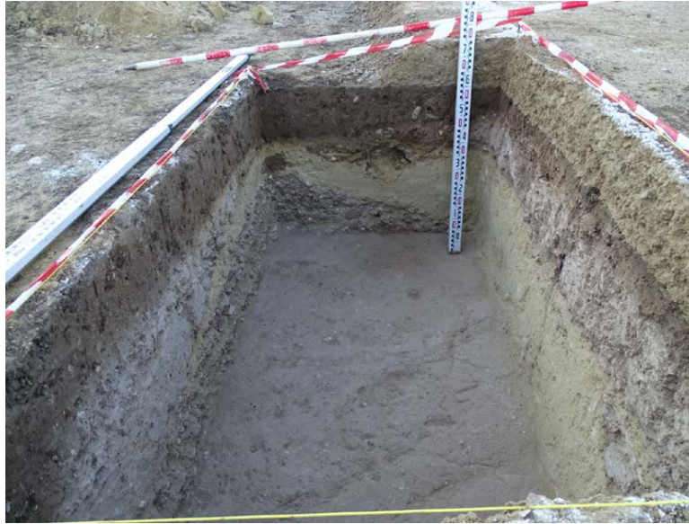
Lám. III: Planta final y perfiles de la Zapata 13 tras su excavación manual.
