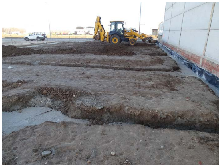
Lám. VII: Vista de la parcela tras el hormigonado de las zapatas y zunchos.
