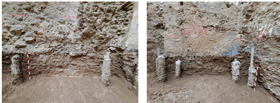
Ilustraciones 3 y 4. Detalle de los perfiles una vez ejecutados el rebaje sin control arqueológico
