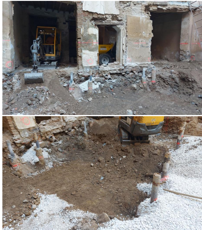
Ilustraciones 14-15. Excavación del foso de grúa.
