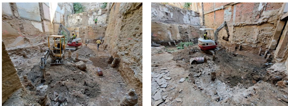
Ilustraciones 1 y 2. Vista general del solar una vez ejecutado el rebaje en algo más de 1 m de profundidad
