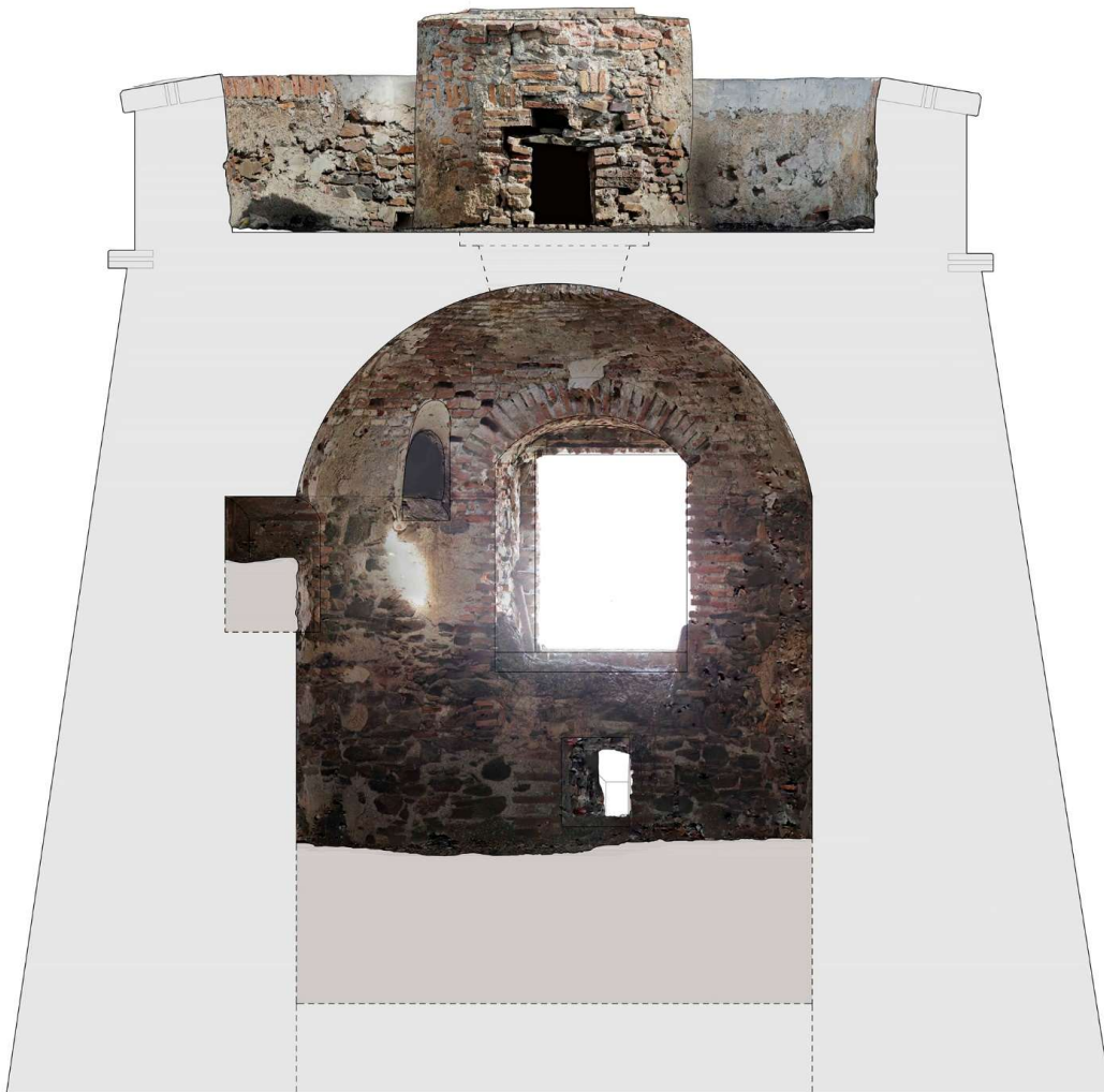
Figura 12: Sección del habitáculo de la torre donde se aprecia el nivel de relleno en su interior y la puerta de salida a la terraza rehecha de forma poco rigurosa con trozos caídos de fábrica.
