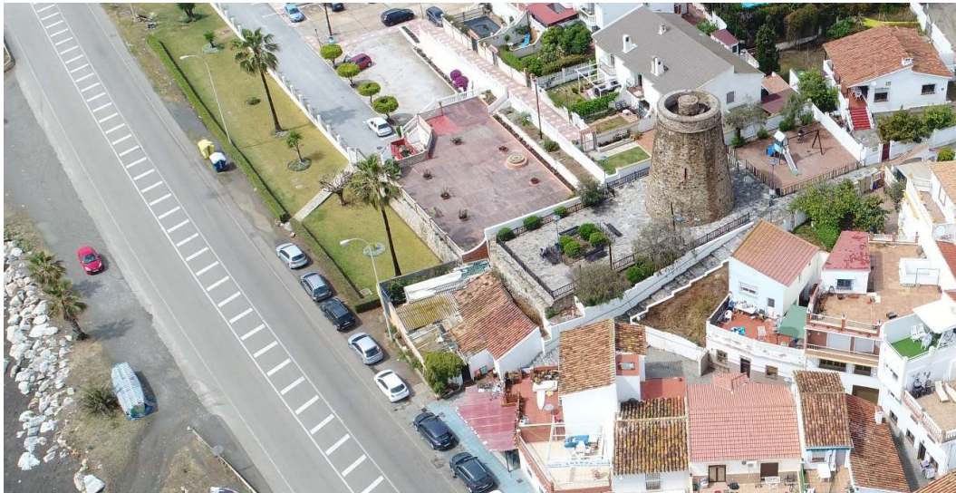
Figura 1. Fotografía aérea de la Torre de Chilches y su entorno. L.J. García Pulido, 2019.
