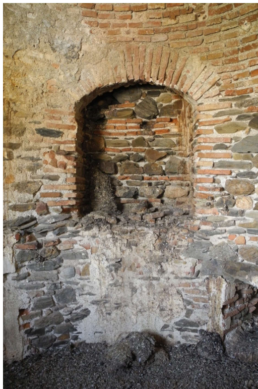
Figura 10: Chimenea conservada en el interior rematada con arco rebajado de ladrillo.
