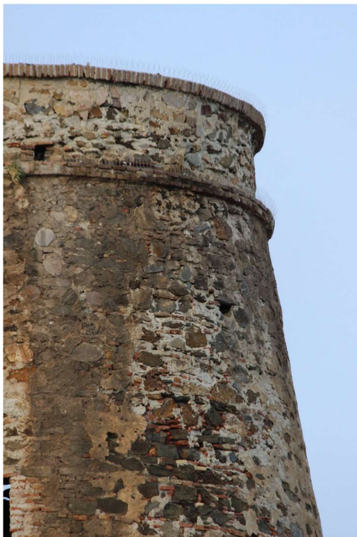
Figura 7: Detalle del perfil de la torre donde se aprecia el sistema constructivo y la solución de remate de la terraza.
