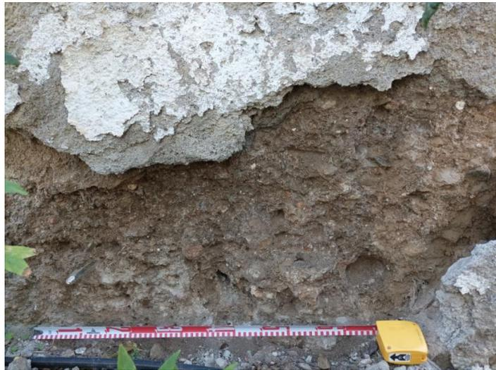
**Lámina 1:** Fábrica de tapial hormigonado (1) en la base de la tapia medianera.
