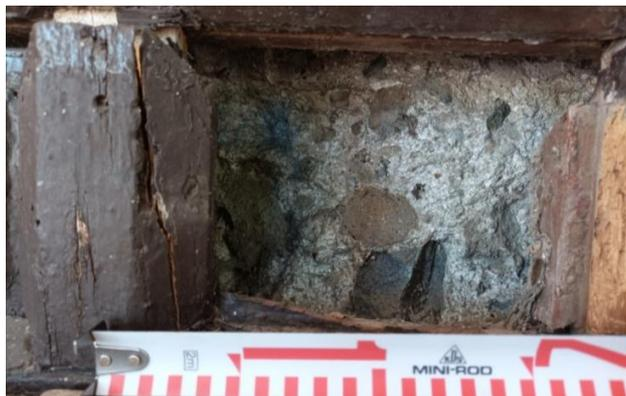
**Lámina 2:** Detalle del tapial hormigonado de la estructura (2) tras la falsa puerta.
