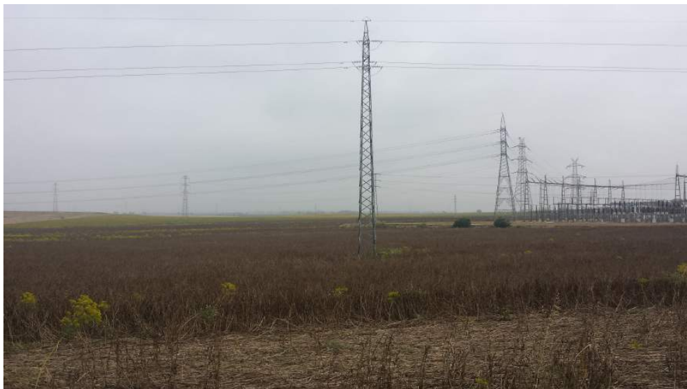
Lám. XCIV. Tramo 2. Sector único.
