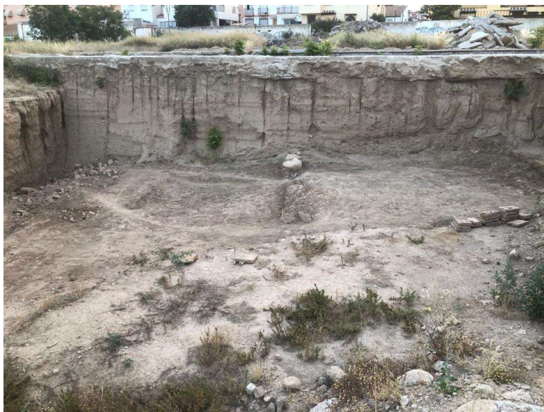
Fig. 2: Vista estado final parcela PR1
