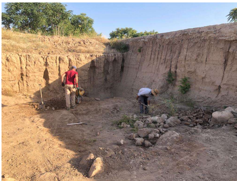
Fig. 1: Detalle de desmontaje de muros en PR1
