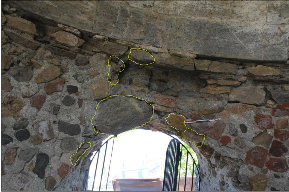
*Figura 101. Propuesta de aplicación de mortero en los mampuestos en el paramento interior norte sobre el arco de entrada.*
