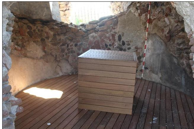
*Figura 49. Estado del interior de la torre tras instalar el pavimento de madera, la iluminación y el pedestal donde se situará la maqueta de la torre.*
