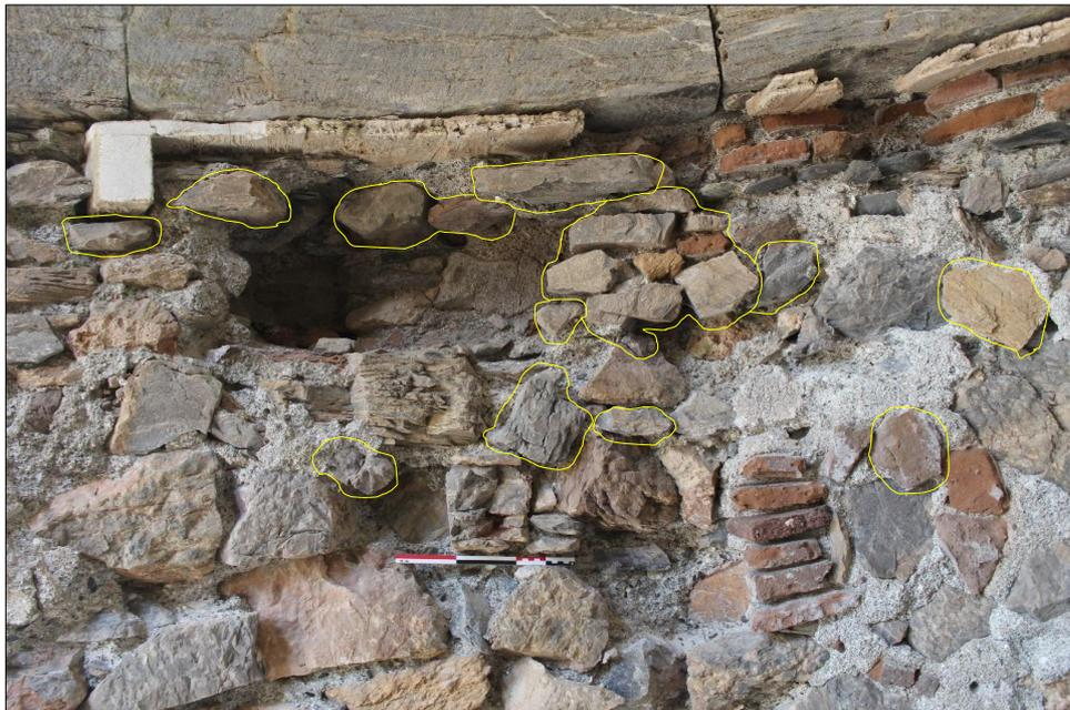
*Figura 100. Propuesta de aplicación de mortero en los mampuestos del paramento interior oeste.*
