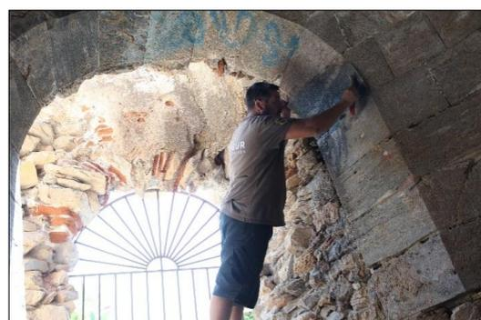
*Figura 21. Trabajos de limpieza de grafitis en el exterior e interior del BIC.*
