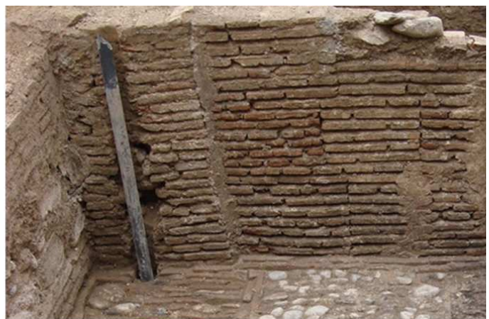
Murete de ladrillo que separa las dos habitaciones. Uno de los muros principales de la crujía. Se ven los cajones de tierra y piedras con verdugadas de ladrillo.
