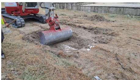
Fig. 2: Proceso de excavación del sondeo.
