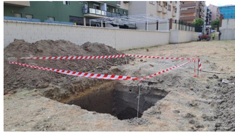
Fig. 4: Sondeo finalizado y balizado.
