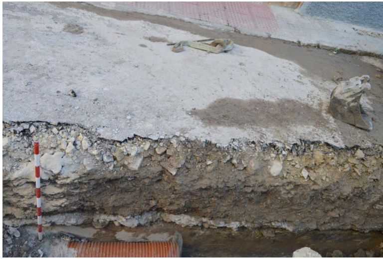
Fig. 7. Zanja de saneamiento. Plaza de San Juan de Dios.
