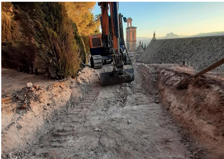
Fig. 4. Rebaje del terreno en el sendero del lado este de la Alcazaba.
