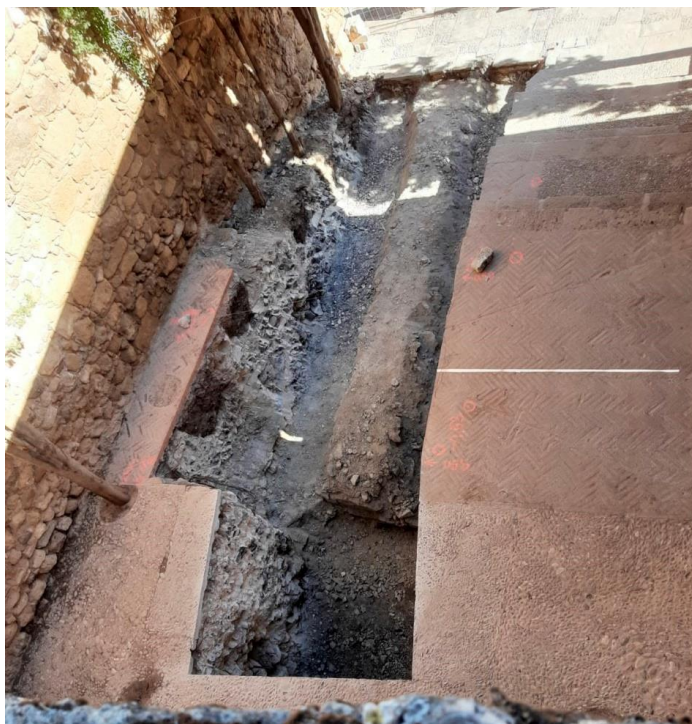
Fig. 2. Apertura de caja para rampa y ascensor a la entrada de la Alcazaba.
