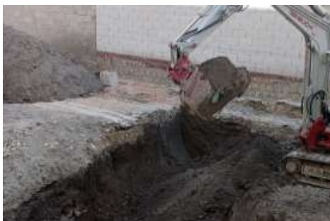
Fig. 3: Proceso de excavación de la maquinaria.
