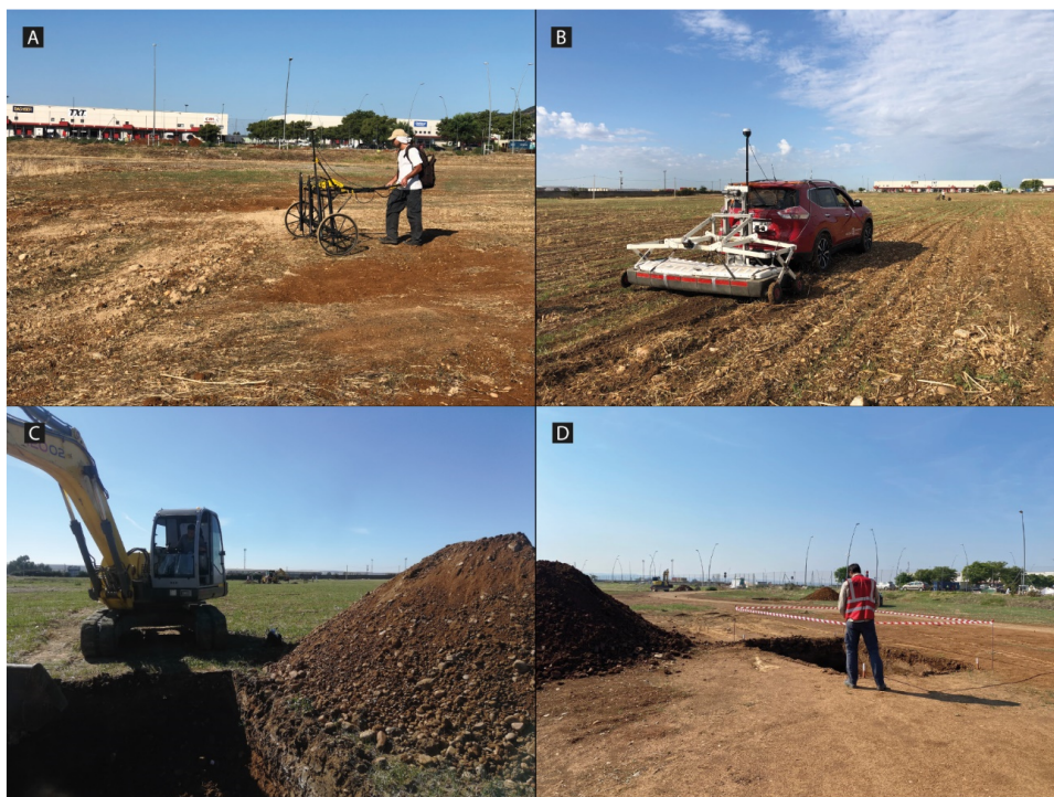
Ilustración 2. Acciones de registro realizadas durante la intervención: prospección magnética (A), prospección mediante georradar (B), excavación mecánica de sondeos (C) y documentación de carácter técnico-arqueológico (D)
