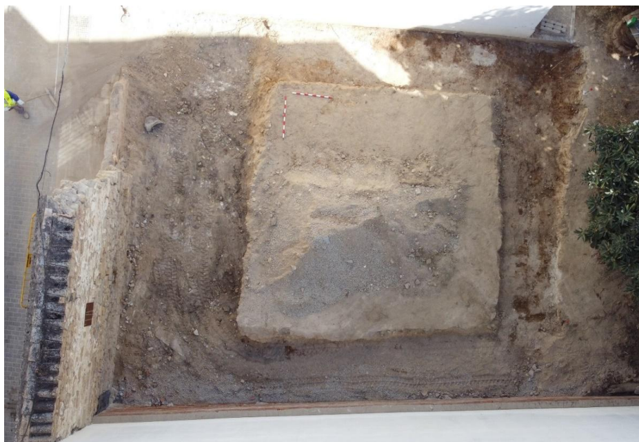
Lámina III. Vista aérea de la zona afectada por las obras tras su finalización.
