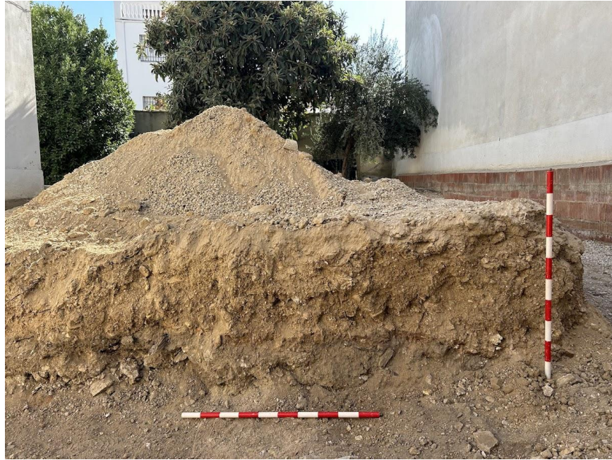
Lámina II. Detalle perfil excavado en la zona Oeste de la zona de obras.
