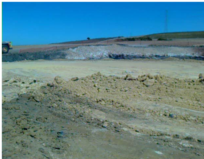
Lám. IV. Detalle de los trabajos de explanación de la subestación.
