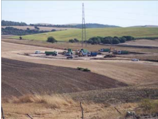
Lám I. Vista general. Inicio del movimiento de tierra.
