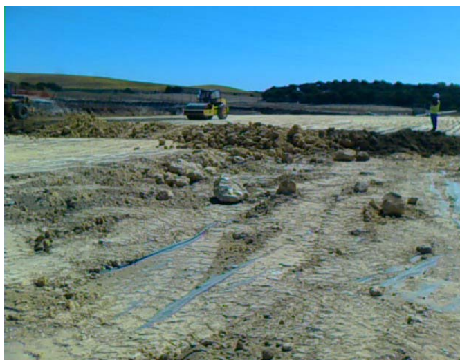
Lám. V. Superficie de la subestación durante los trabajos de explanación.
