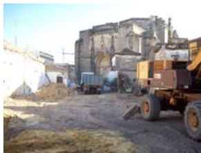
Vista del solar. Imagen previa a la intervención arqueológica.
