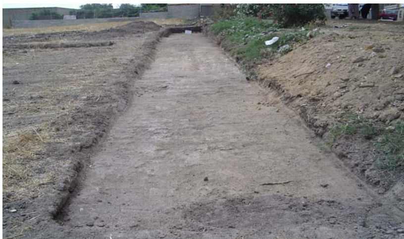
LÁM. II. Vista general del C-1 tras la excavación.
