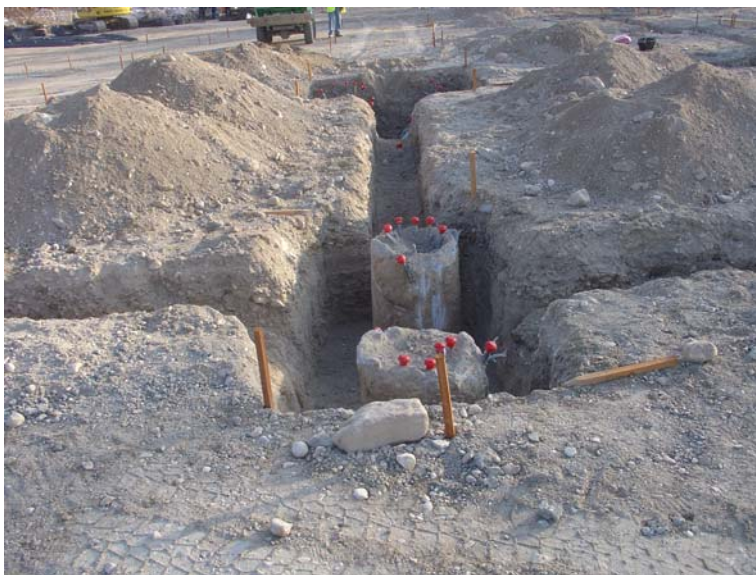
Lám.3.Apertura de zanjas para pilotes.
