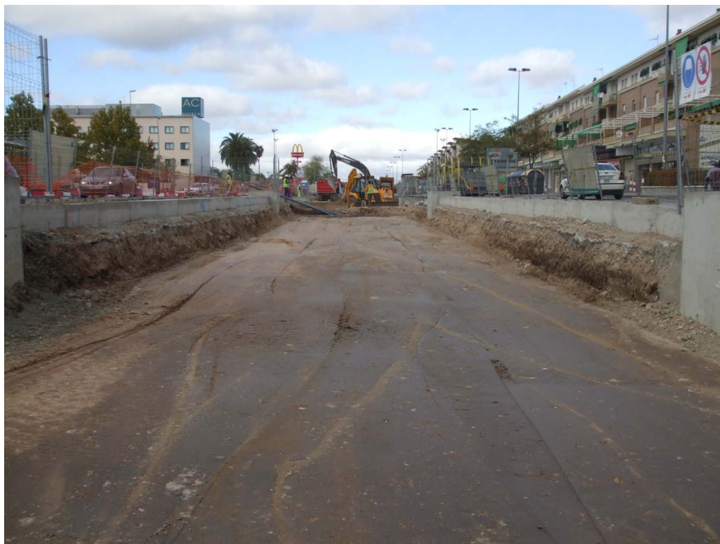
Panorámica de la Carretera de Jaén. Cajeo central.
