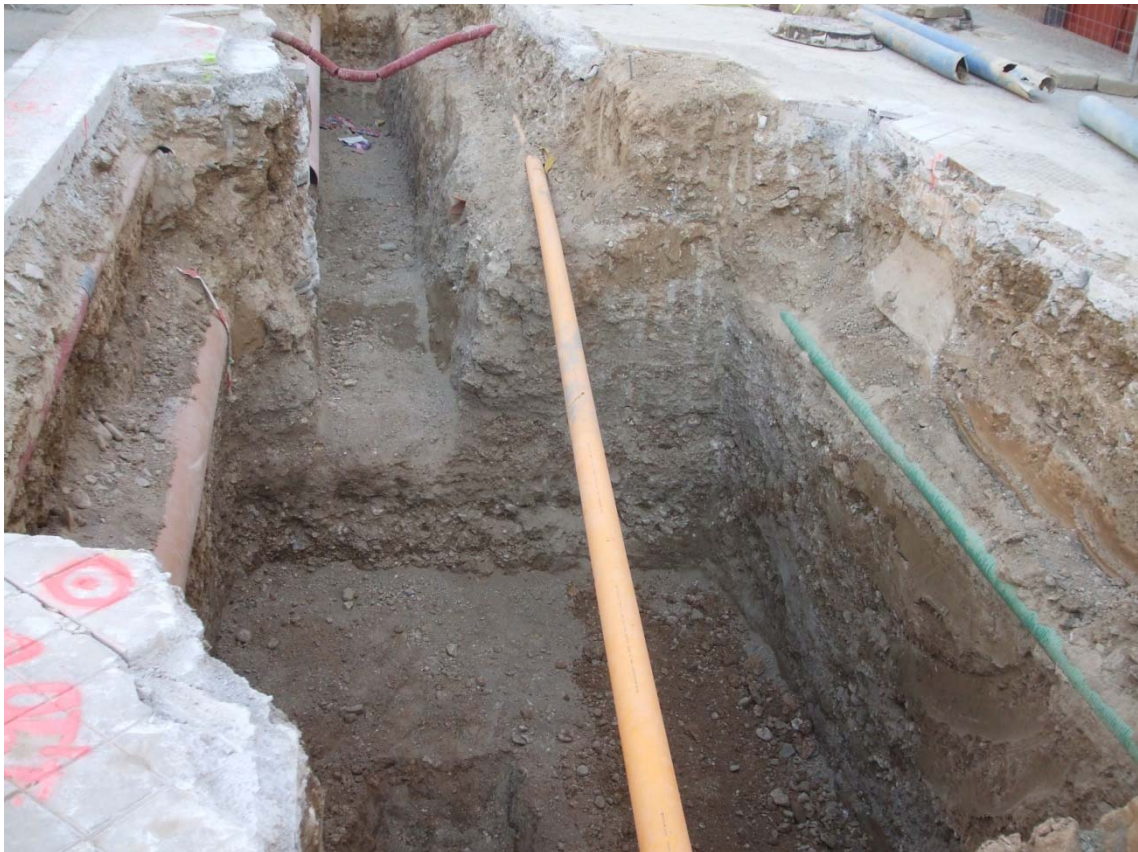
Zanja. Avenida de Maracena.
