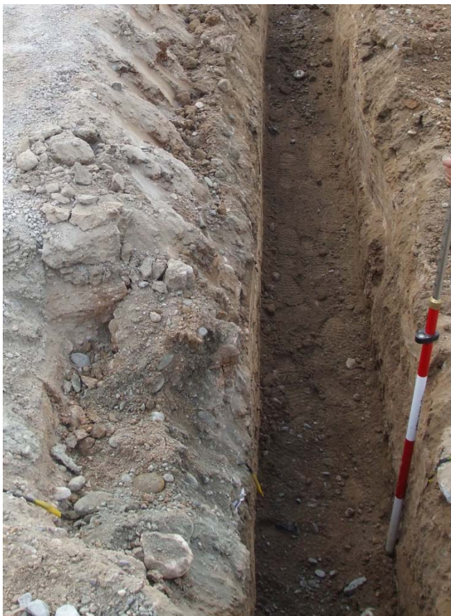
Zanja. Carretera de Jaén.
