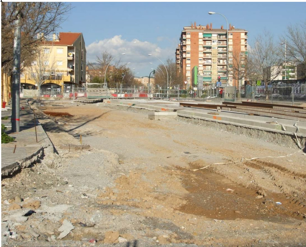
Panorámica del cajeo en la Calle Sol y Sombra.
