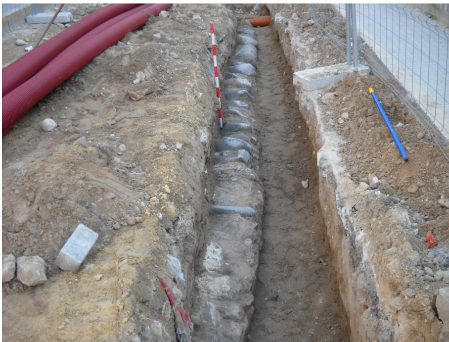
Figura 2. Tramo de la tubería de abastecimiento de agua en C/ Jesus de los Milagros, con cubrición protectora de bolos y mortero.
