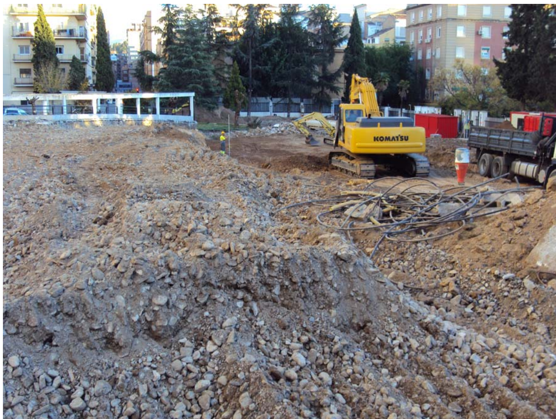
Foto 1. Retirada de las capas superficiales.
