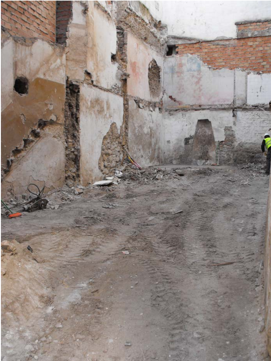
Vista general del solar tras la demolición de la vivienda.
