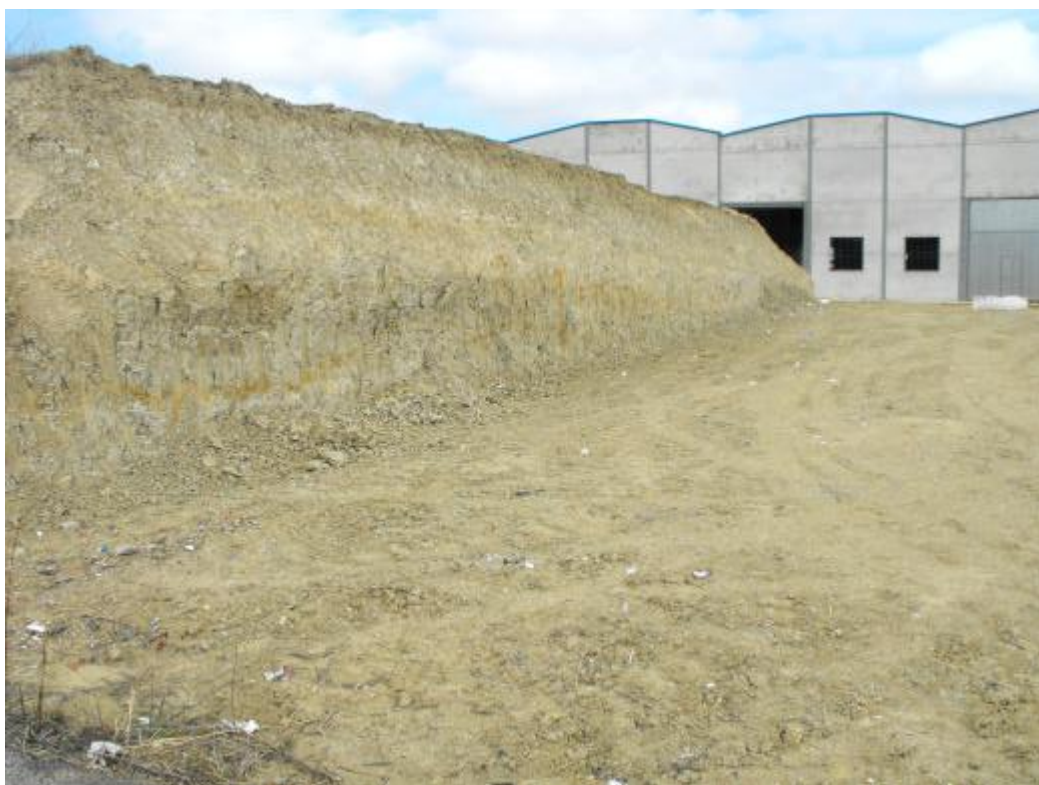
Vista general de la parcela nº 89 a la finalización de los trabajos arqueológicos
