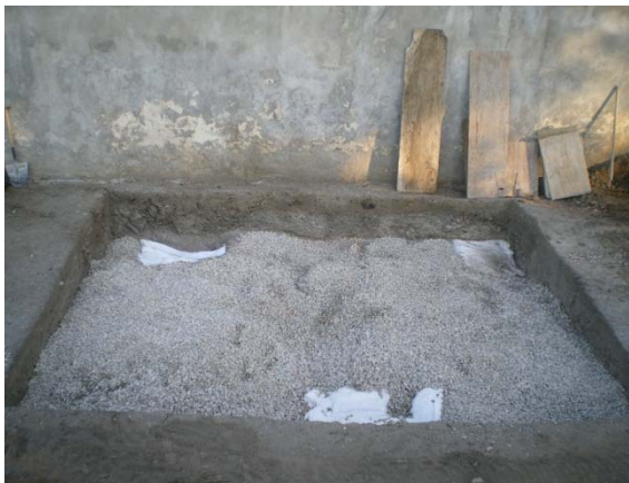
Sondeo nº 3, cubrimiento geotextil y gravas
