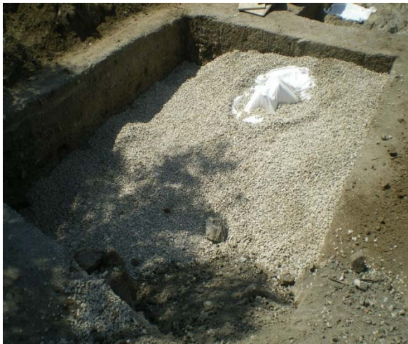
Sondeo nº 4, cubrimiento geotextil y gravas
