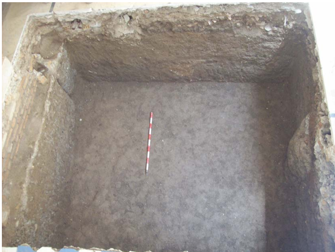
Fig. 5. Vista final de la intervención en el hueco del ascensor.
