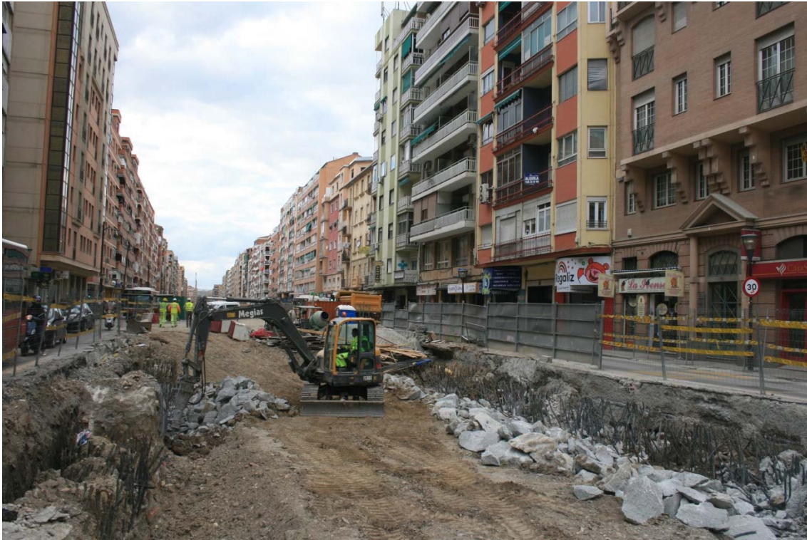
Proceso de excavación de niveles superficiales
