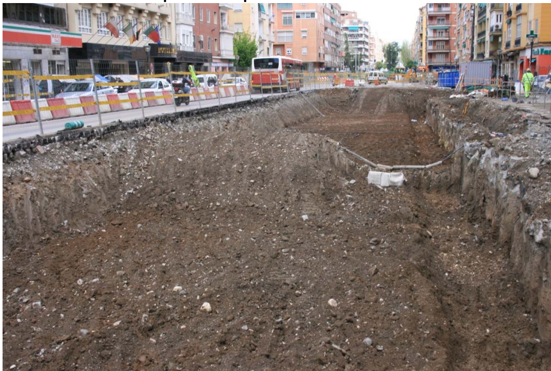
Demolición de aglomerado y retirada de relleno superficial
