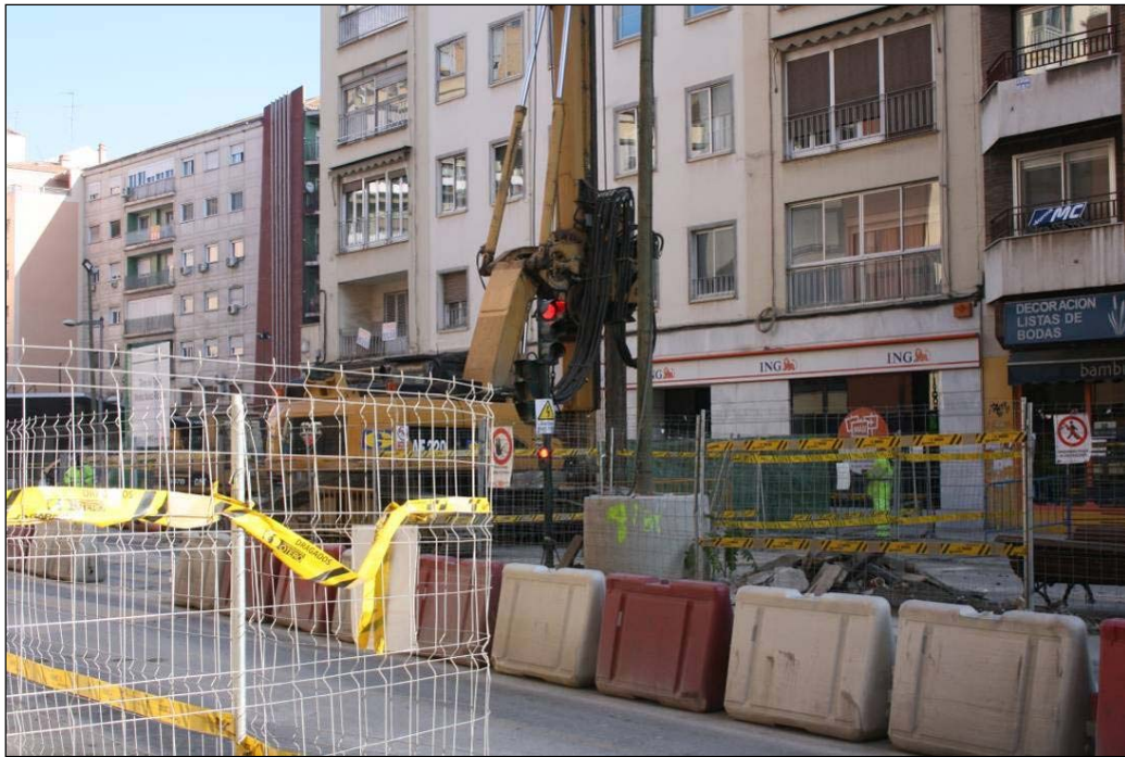
Proceso de pilotaje perimetral
