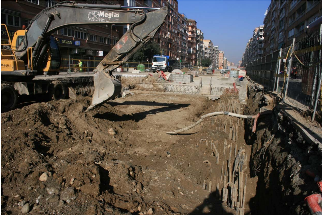
Proceso de excavación de niveles superficiales
