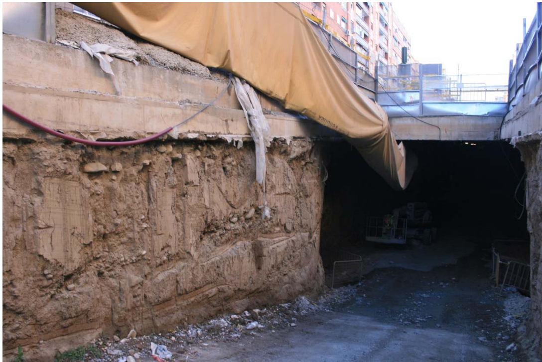
Excavación en mina
