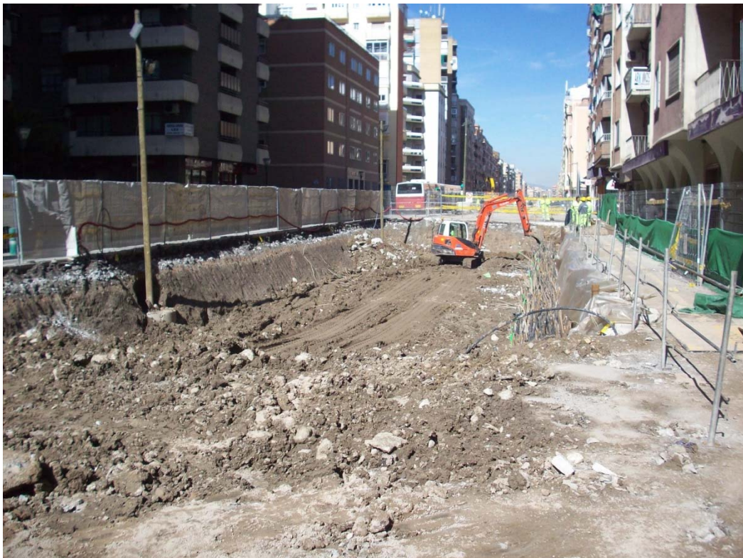
Proceso de excavación de niveles superficiales
