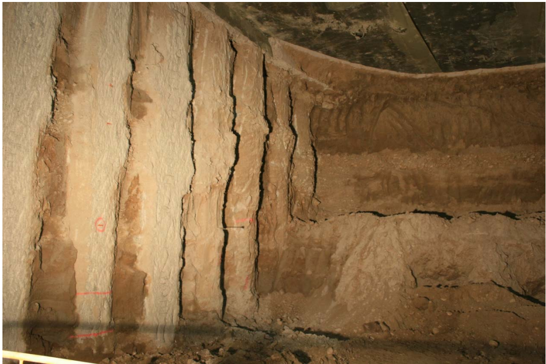
Excavación en mina
