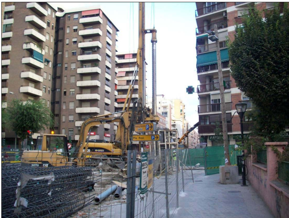
Proceso de pilotaje perimetral
