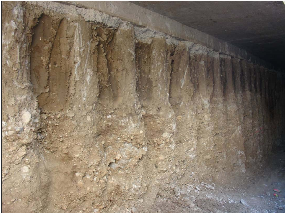
Vista de la pantalla de pilotes desde el interior del túnel
