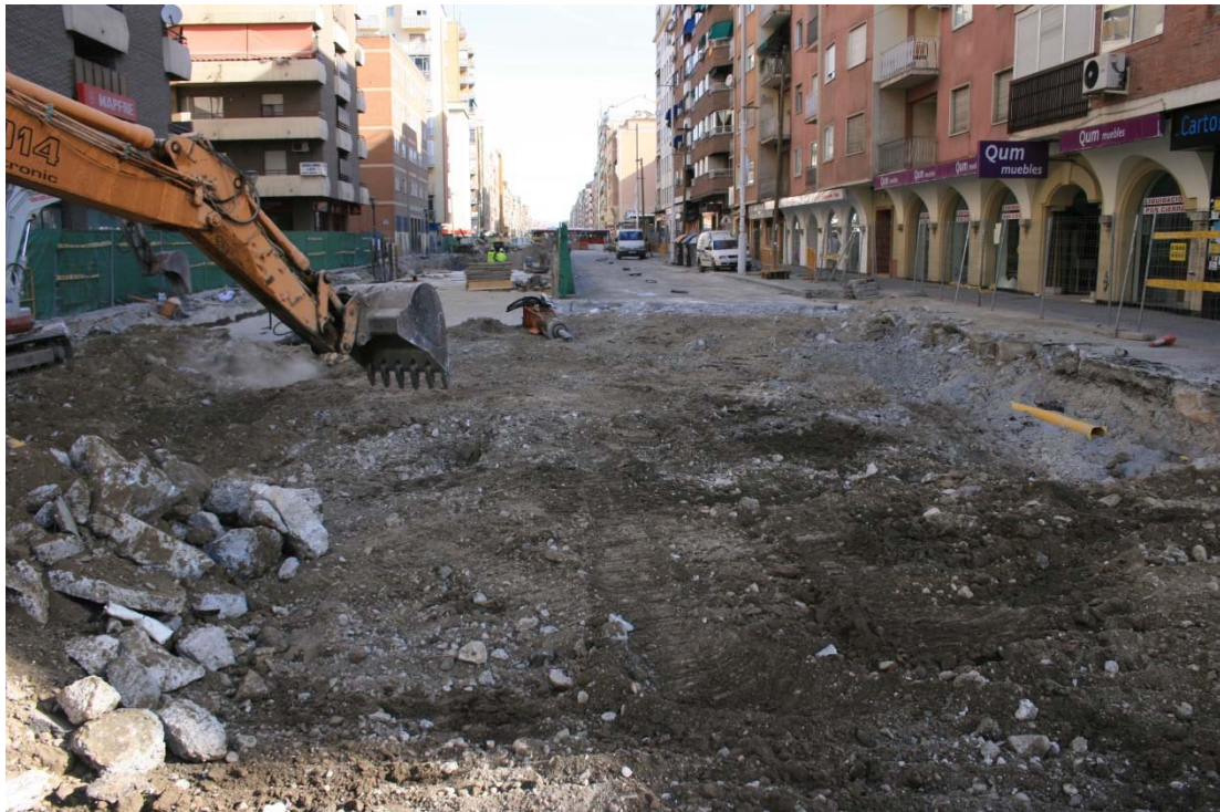
Proceso de excavación de niveles superficiales
