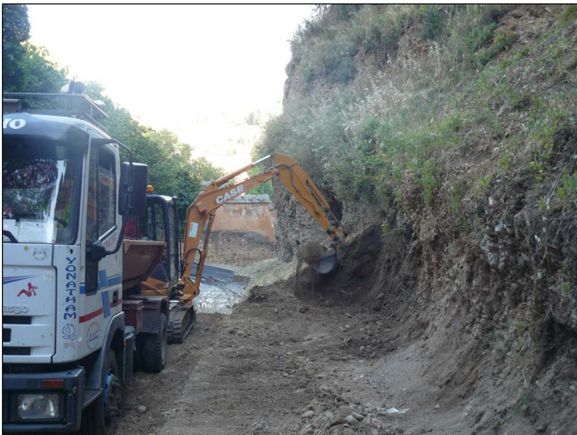
Imagen: Limpieza de taludes, se observa la gruesa capa de derrubios UE-001.
