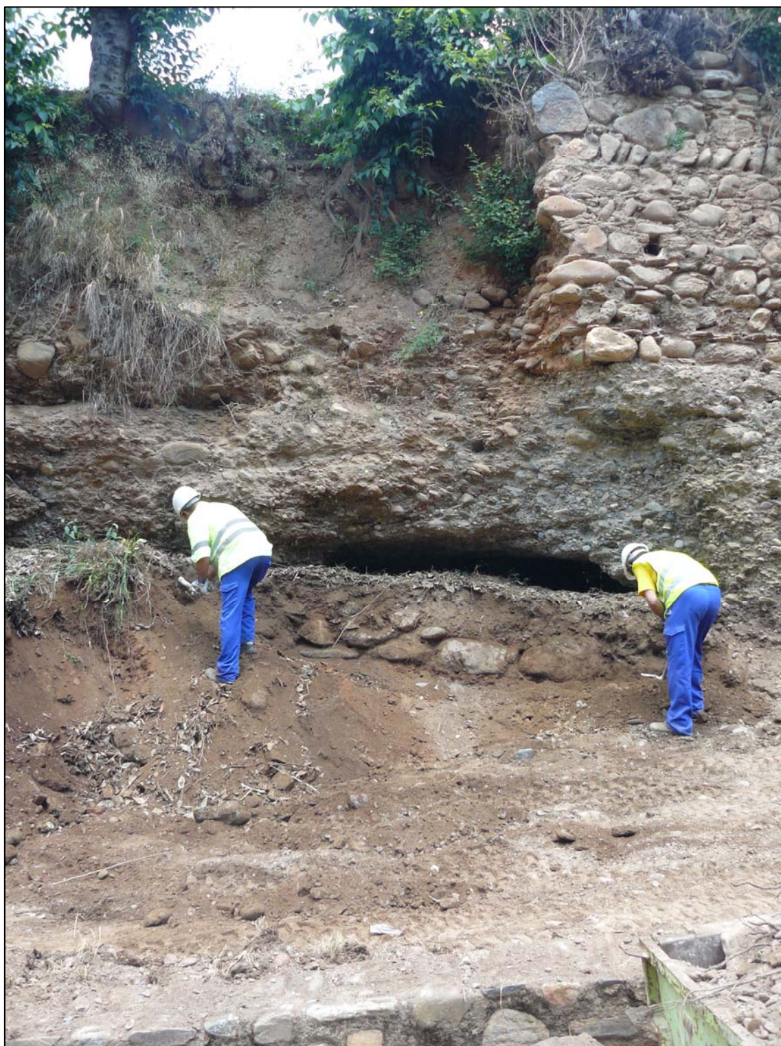
Imagen: Detalle de la limpieza manual del talud en la Zona I en el momento que se documenta el muro UE-003. Posiblemente relacionado con una reparación del muro superior así como con una actuación para contener la
