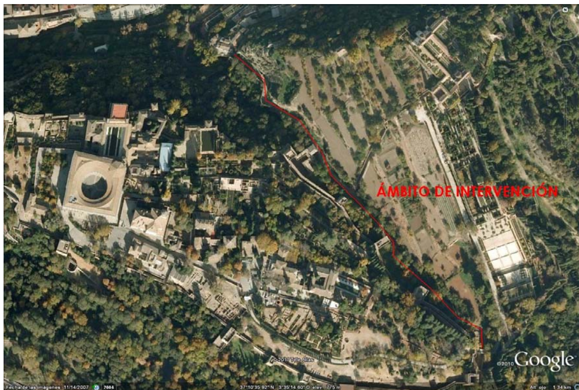
Vista general de la zona de intervención
