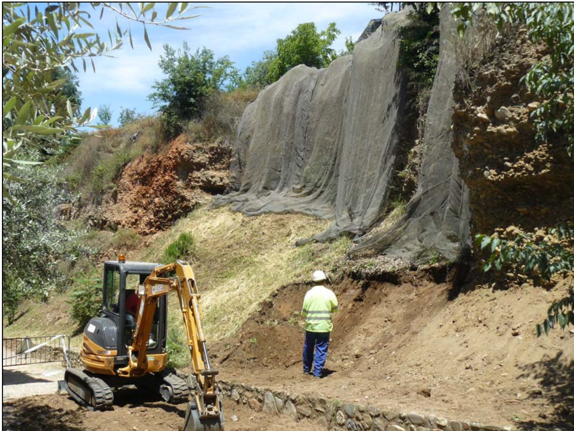
Imagen: Una vez hecha la zanja junto al muro de mampostería y limpio el talud del nivel de derrubios se colocan las mallas de protección.
