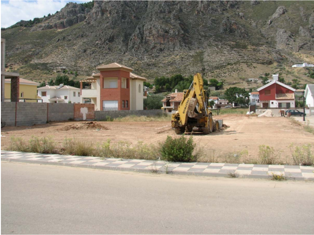
Fig. 9. Parcela 29 al inicio de la intervención.
