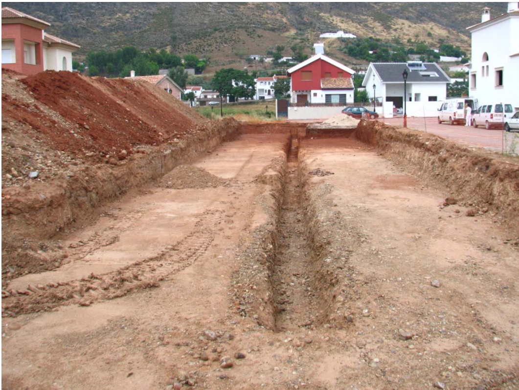
Fig. 13. Parcelas 27 y 44 una vez intervenidas y con la zanja de seguridad completada.
