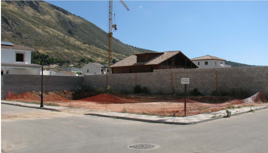
Fig. 6. Parcela nº 29, calle Darwin, finalizada.
