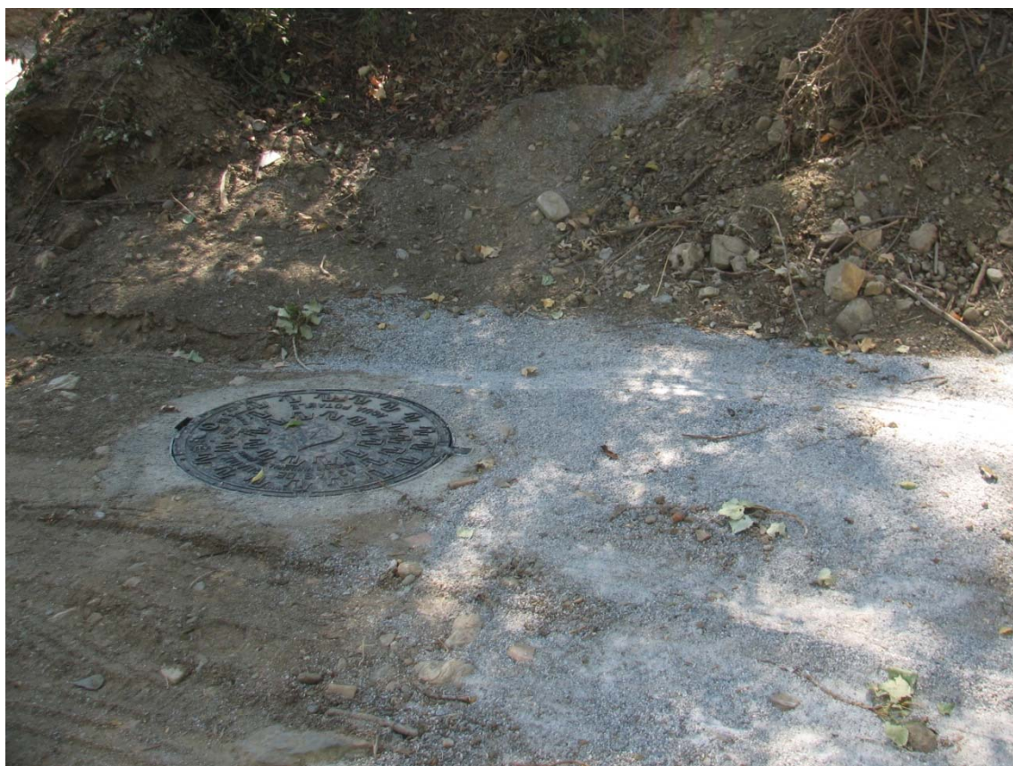
Fig. 14: Arqueta en el área de trazado.
