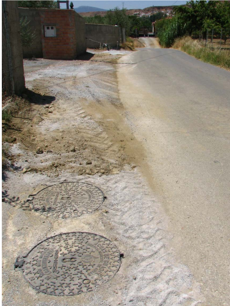
Fig. 17: Arquetas en el área de trazado.
