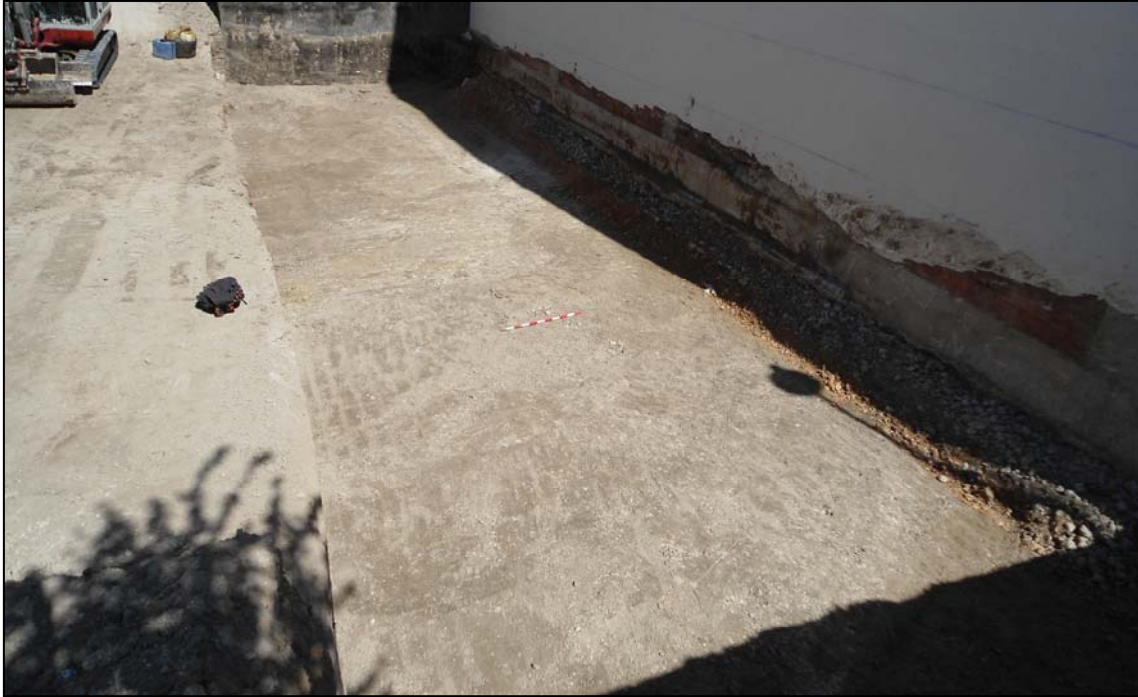
Lám. II. Vista general de la parcela, una vez finalizados los trabajos de destierro.
