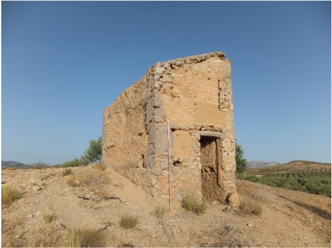
(LÁM. II. Construcción contemporánea, construida a base de tongadas de tapial)
