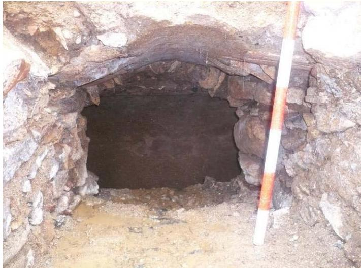
Lámina 4. Conexión entre la U.E. 5 y el colector U.E.6.
