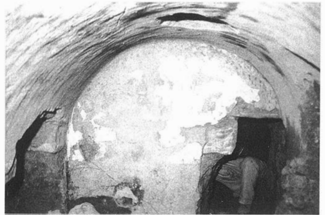
LAM. IV. Criptas de enterramiento, con las aperturas practicadas en sus muros con el objetivo de facilitar la circulación de aire y el tránsito por la Galería de Aireación.
