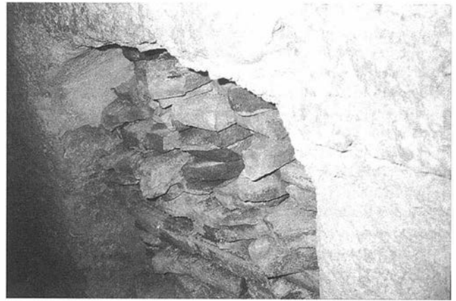
LAM. V. Acceso original a la Galería de Aireación desde la iglesia. En la actualidad se encuentra cegada con losas de cerámica decoradas con bajos relieves.
