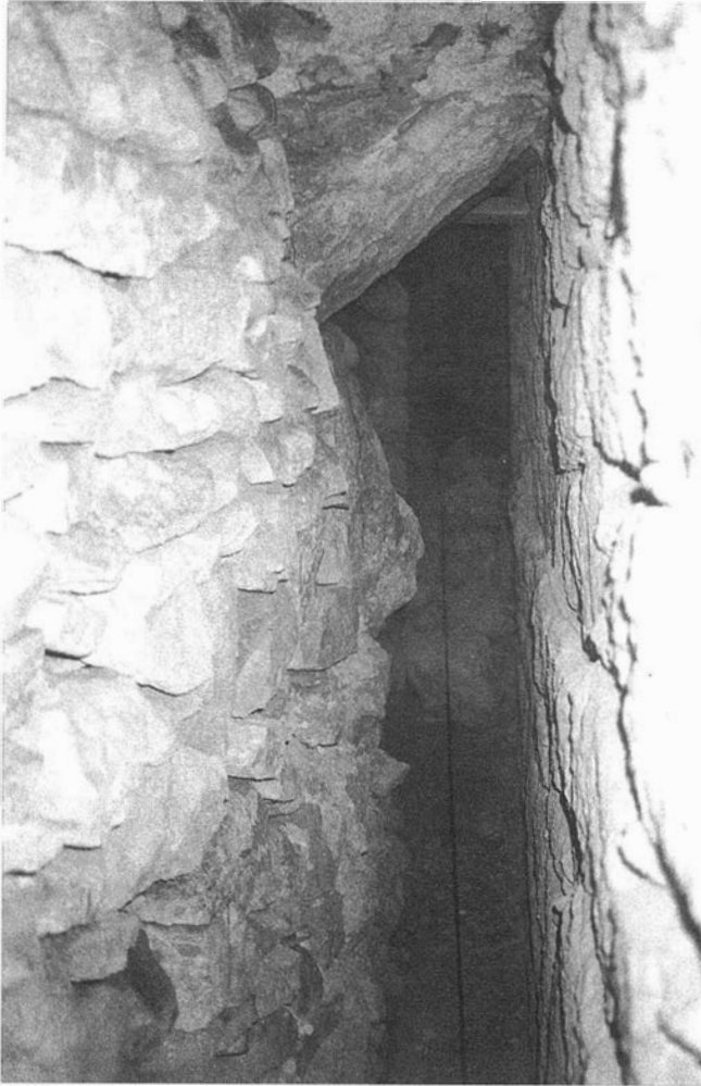
LAM. III. Tramo de la Galería de Aireación del Muro Oeste de la Iglesia
