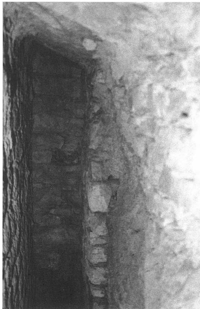
LAM. II. Galería de Aireación del Muro Oeste de la Iglesia. En la misma se localiza una apertura practicada para acceder al interior de una cripta de enterramiento.
