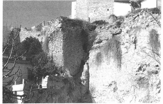
LAM. III. Tramo del lienzo Sur de la Muralla de Jaén. Estructuras de Tapial revestido de mampostería, y lienzos de mampostería colindantes con el Huerto del Convento de la Merced.
