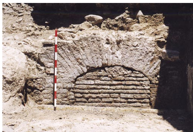
LAM. II. Arco cegado bajo el muro emergente.
