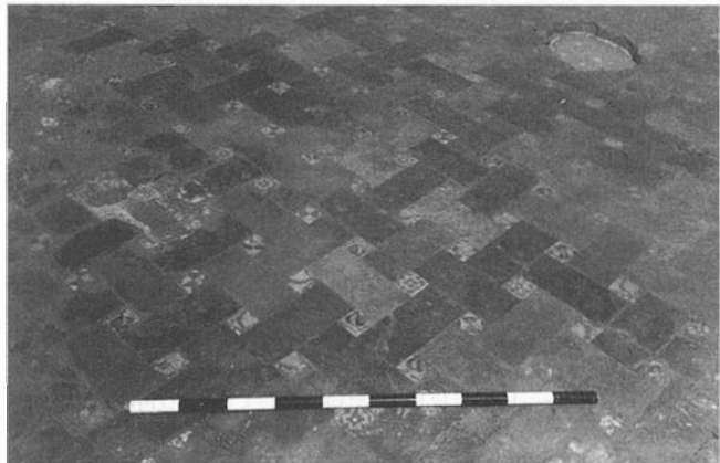
FIG. 3. Detalle de la solería de la Sacristía.
