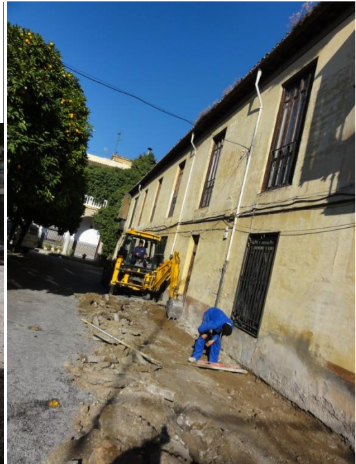
Lams. 1, 2 y 3. Distintas vistas del rebaje de las zanjas perimetrales en el patio.
