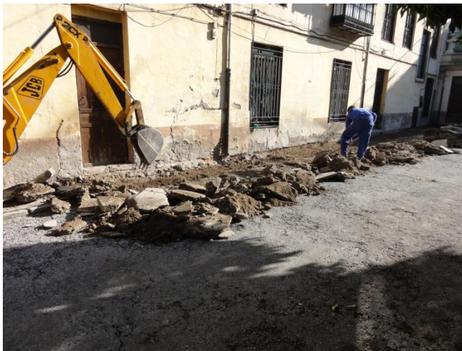
Lams. 1, 2 y 3. Distintas vistas del rebaje de las zanjas perimetrales en el patio.
