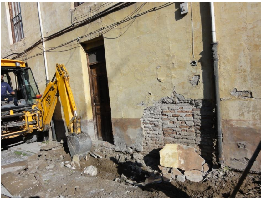
Lams. 1, 2 y 3. Distintas vistas del rebaje de las zanjas perimetrales en el patio.
