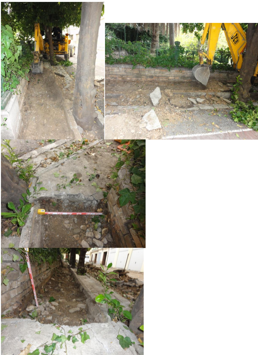
Lams. 8, 9, 10, 11, 12 y 13. Vista del pavimento del jardín, y el rebaje para su acondicionamiento.
