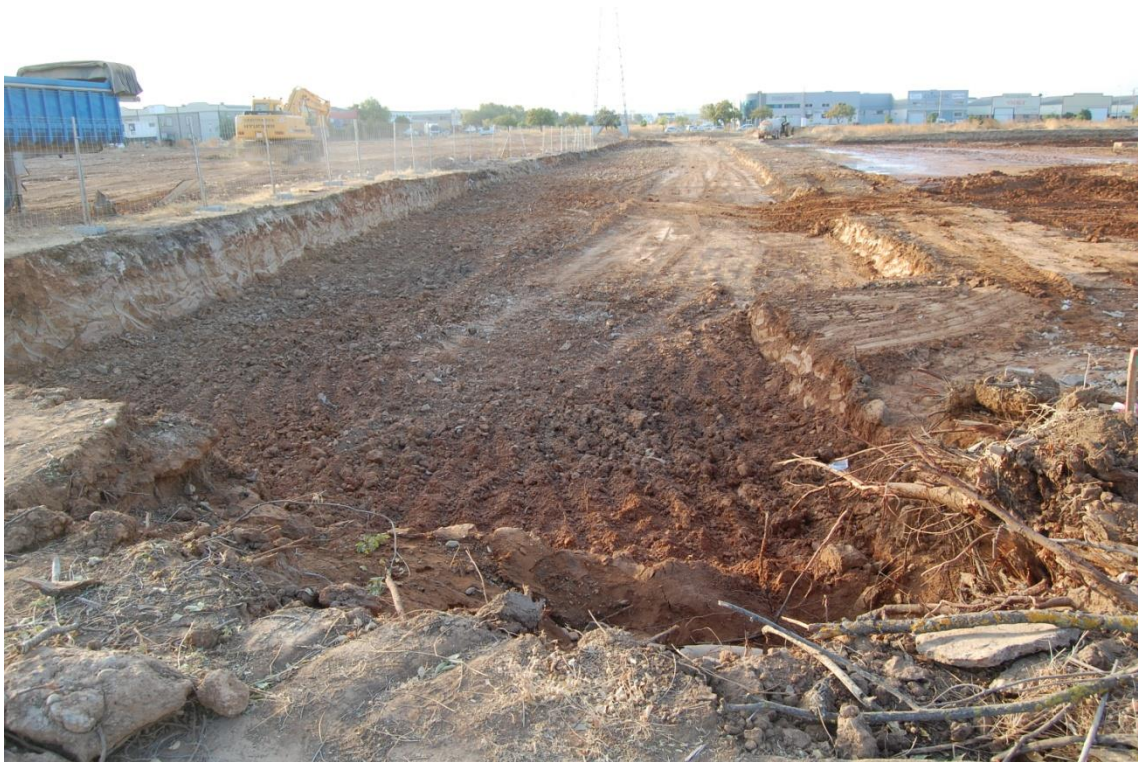
Lámina IV. Vista del vial de nueva apertura una vez concluido el rebaje inicial.
