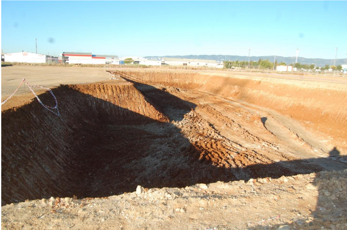
Lámina V. Excavación del foso para los pozos de inspección de vehículos.
