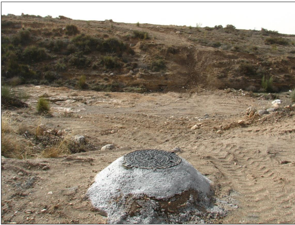
Figura 3: paso de la conducción por la rambla.
