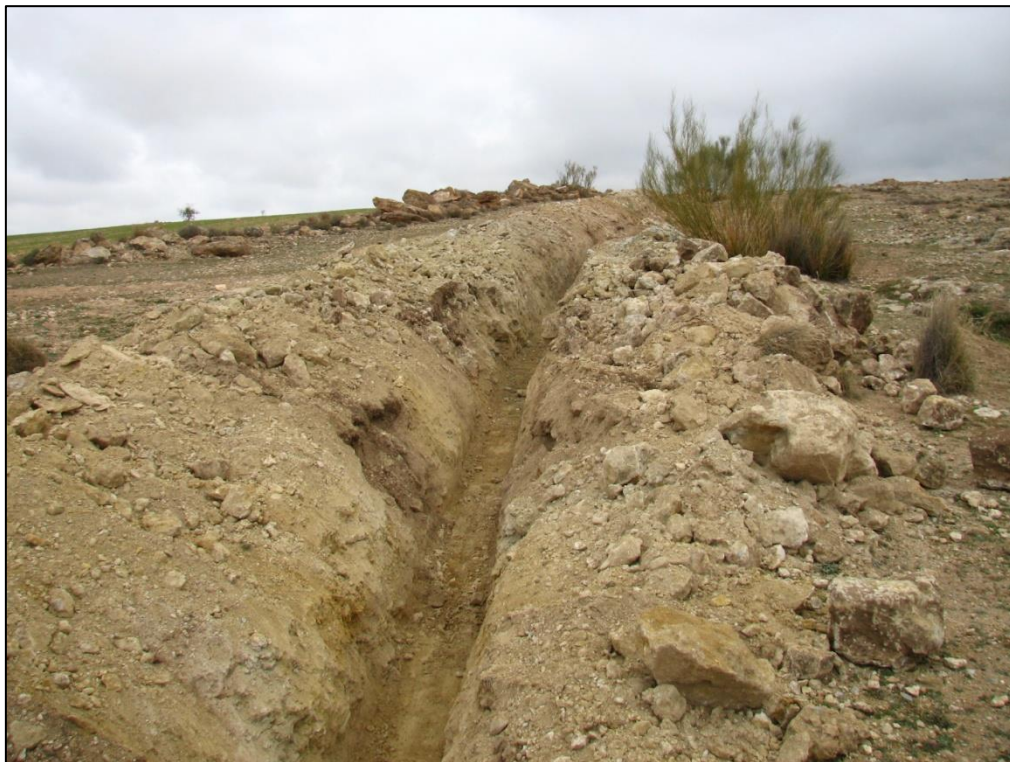
Fig. 26: trazado de la zanja en el área inmediata a la carretera.
