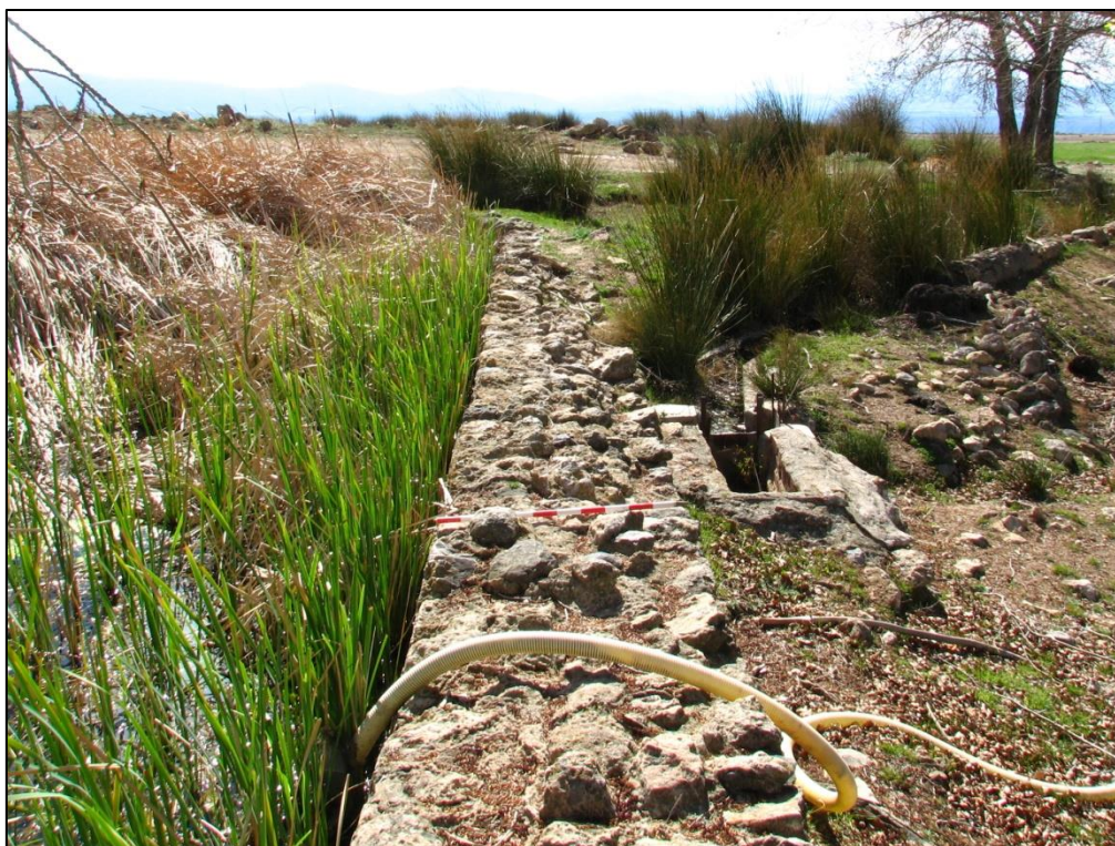
Fig. 61: vista del muro E-O de la balsa
