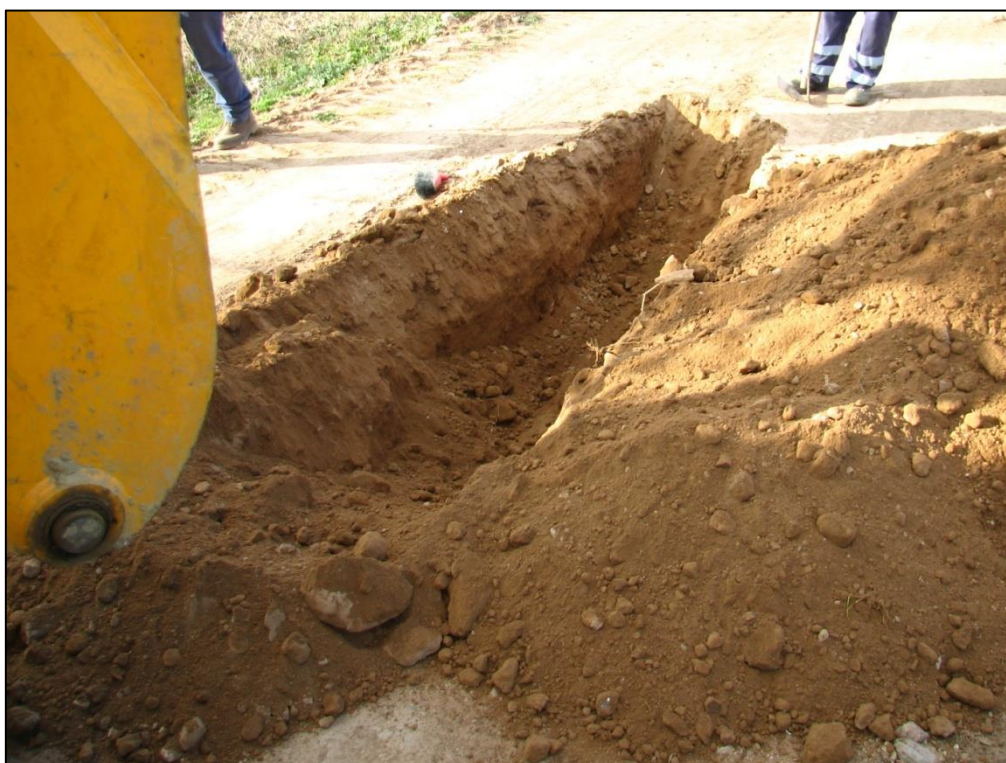
Fig. 17: excavación del sondeo 5.
