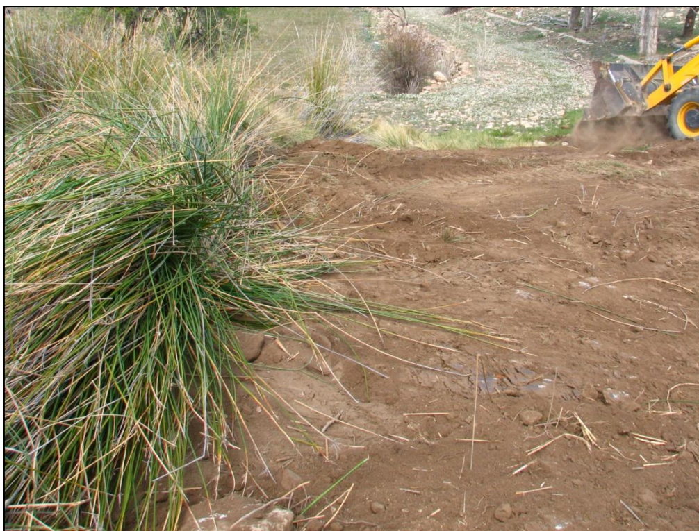
Fig. 70: zona del sondeo tras su cubrición.
