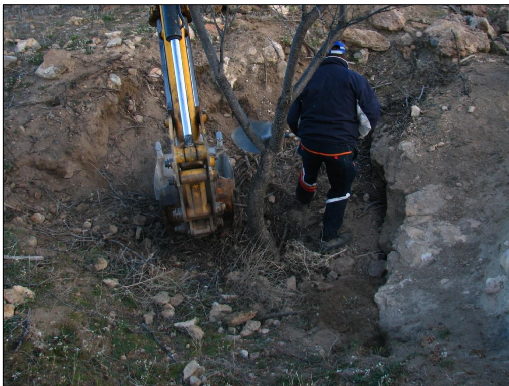
Figura 38: inicio de los trabajos.
