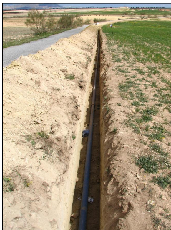
Fig. 27: trazado de la zanja junto a la carretera al sur de Fuente Álamo.
