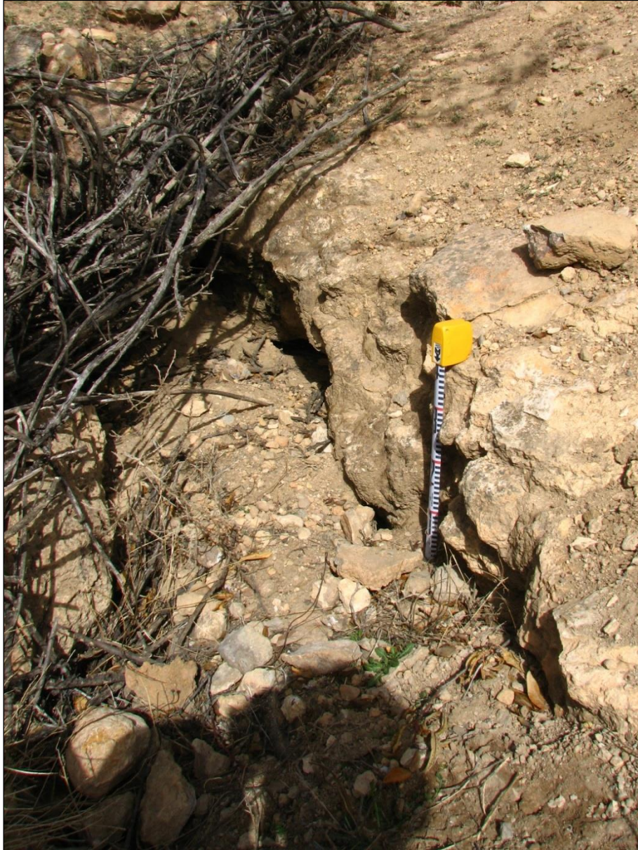
Figura 34: detalle del fondo de la estructura.
