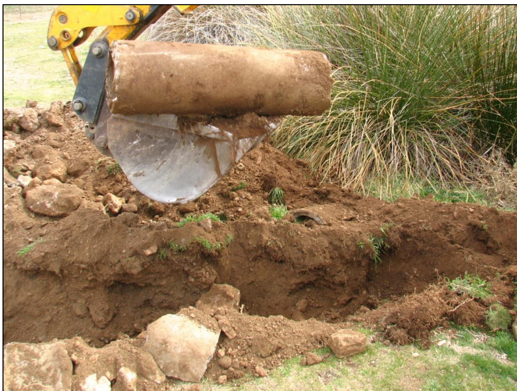
Fig. 24: restos de la antigua tubería de hormigón.
