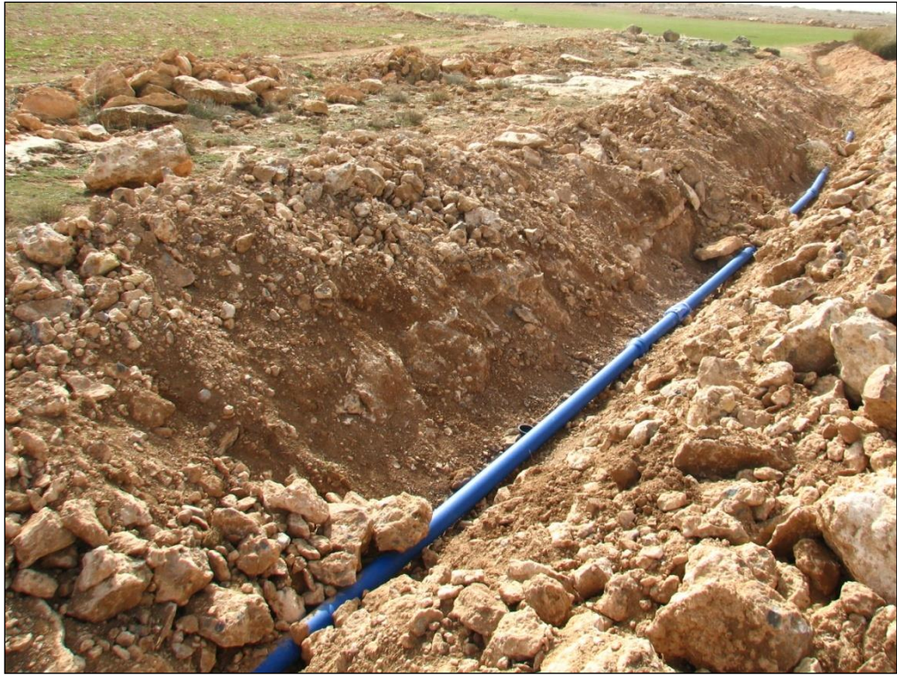
Figura 7: conducción dispuesta en la zanja.
