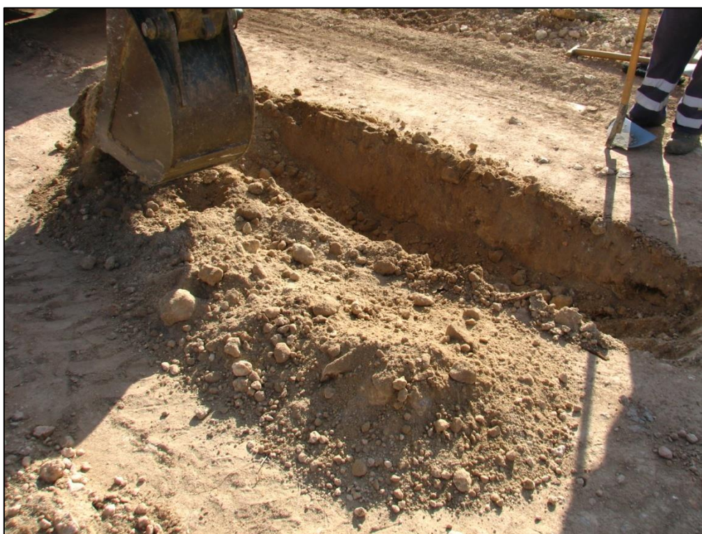
Fig. 14: apertura del sondeo 2.
