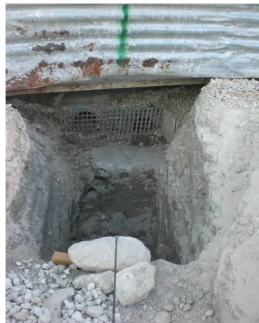
Lám. IX. Acometida de saneamiento del edificio.
