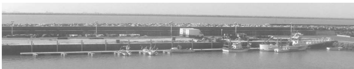
Imagen del pantalán de uso pesquero recientemente instalado en el dique de abrigo
