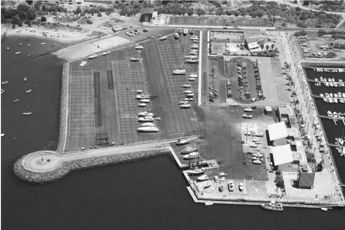
Vista general del nuevo varadero
