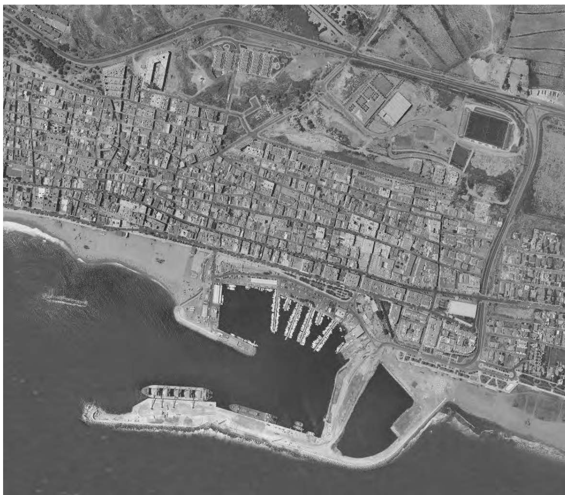
Puerto de Garrucha en 2008, con la ejecución de las obras de ampliación norte.
