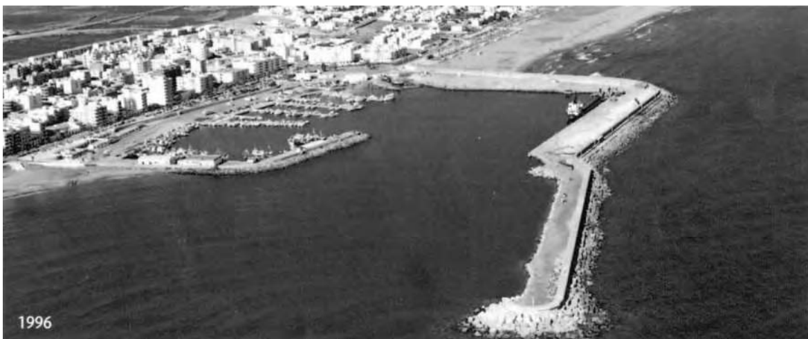
Imagen de 1996 antes de la ejecución del muelle.
