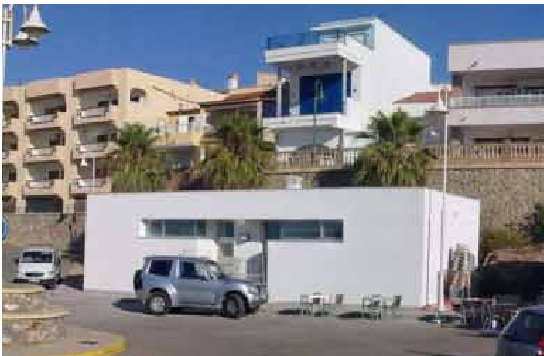
Edificio de duchas y aseos ejecutados en 2010
