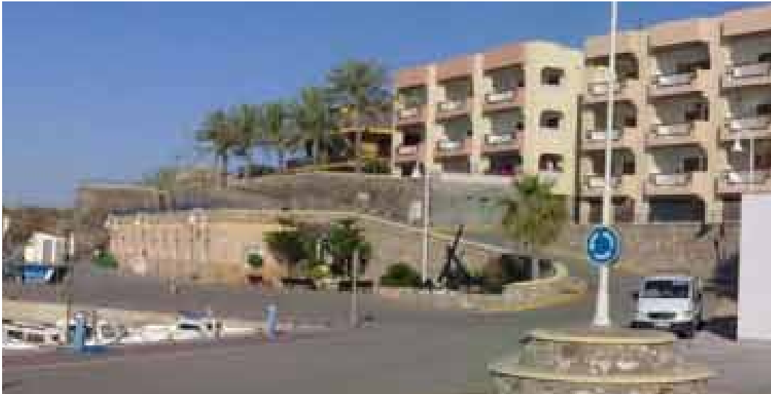
Vista del acceso al Puerto de La Balsa, con los cuartos de pertrechos al fondo
