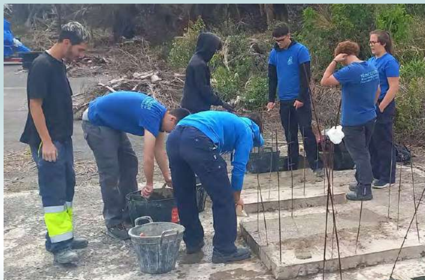
Alumnado construyendo balsas de depuración natural para reducir la huella de carbono en una estación de depuración de aguas residuales
