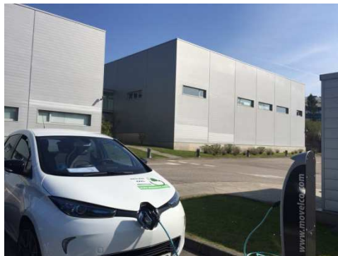
Figura 47. Instalación de punto de recarga en el Centro Tecnológico del automóvil [35]
