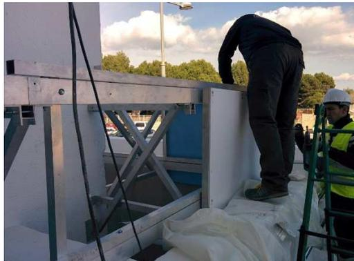
2. Colocación de los paneles SG-P10. Sobre la estructura de aluminio se anclan los paneles de PVC mediante tornillería
