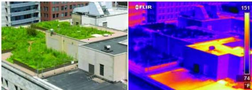
Figura 2 . Diferencia de temperatura superficial entre un techo normal y uno con cubierta verde un día de verano en Chicago [1]
