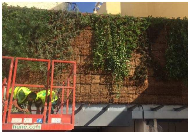
Figura 29. Instalación de jardín vertical [5]
