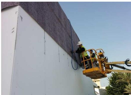
3. Anclaje del sustrato SG-M500 y colocación de tuberías de riego SG-R16. La capa de fieltro se extiende y se grapa a la base de PVC y en la parte superior se coloca la tubería de riego.
