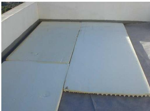
2. Colocación del sustrato. En este caso se optó por planchas de espuma de poliuretano.
