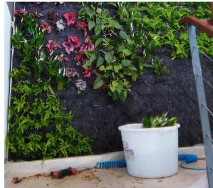
**3 y 4.** Anclaje del fieltro y plantación. Sobre los paneles de PVC se extiende el geotextil, anclado mediante grapas a los paneles de PVC. Una vez finalizado se realiza la plantación dentro de los bolsillos del fieltro.
