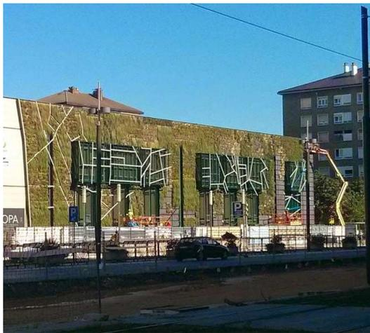
3. Colocación de los paneles de lana de roca sobre la estructura auxiliar.
