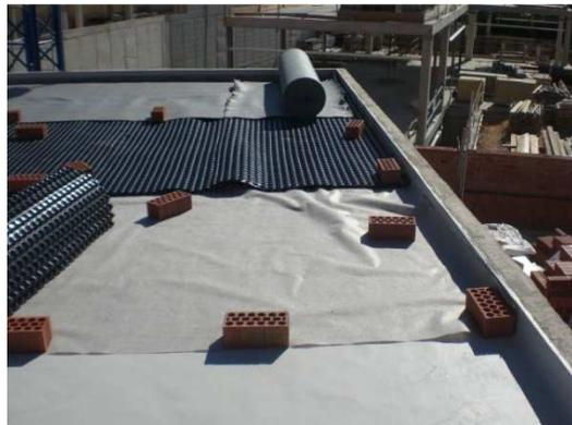
2. Colocación de las capas protectora, drenante y filtrante
