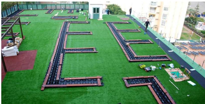
Figura 76. Instalación de los módulos IGNIAGREEN en la cubierta del hotel [8]
