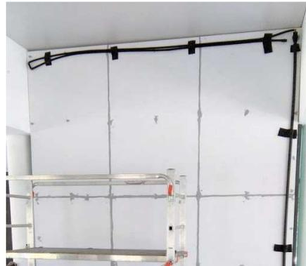
**1 y 2.** Colocación de la estructura, paneles SG-P10 y riego SG-R16. Los perfiles de aluminio se anclan sobre una estructura perimetral. Sobre este rastrelado, se instalan los paneles de PVC y posteriormente el riego.
