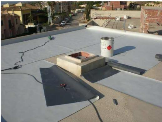
1. Colocación de la impermeabilización. En este proyecto se optó por una impermeabilización en lámina de PVC.
