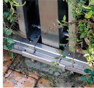
Figura 54. Unión entre bandejas de recogida de agua sobrante POSTDIV [7]
