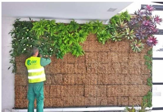
Figura 27. Instalación de jardín vertical con gaviones metálicos [5]
