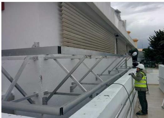
1. Colocación de la estructura. En este proyecto los perfiles se separaron unos 90cm de la fachada, para poder salvar el pasillo inferior.
