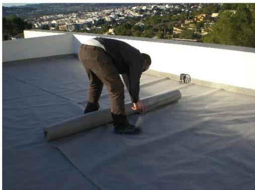
1. Colocación de la impermeabilización en lámina de PVC y capa protectora.
