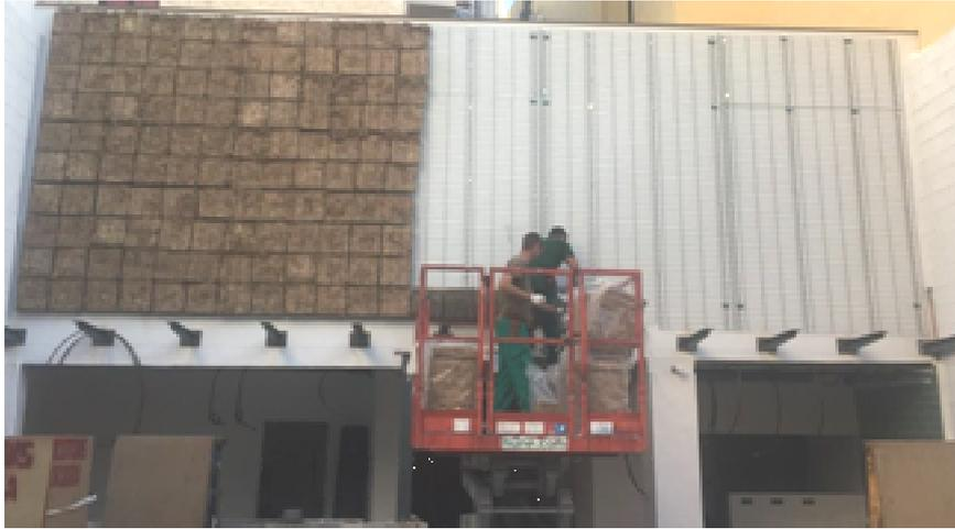
Figura 28. Instalación jardín vertical con gaviones metálicos en el Gastronomo La Galería, Fuengirola (Málaga) [5]
