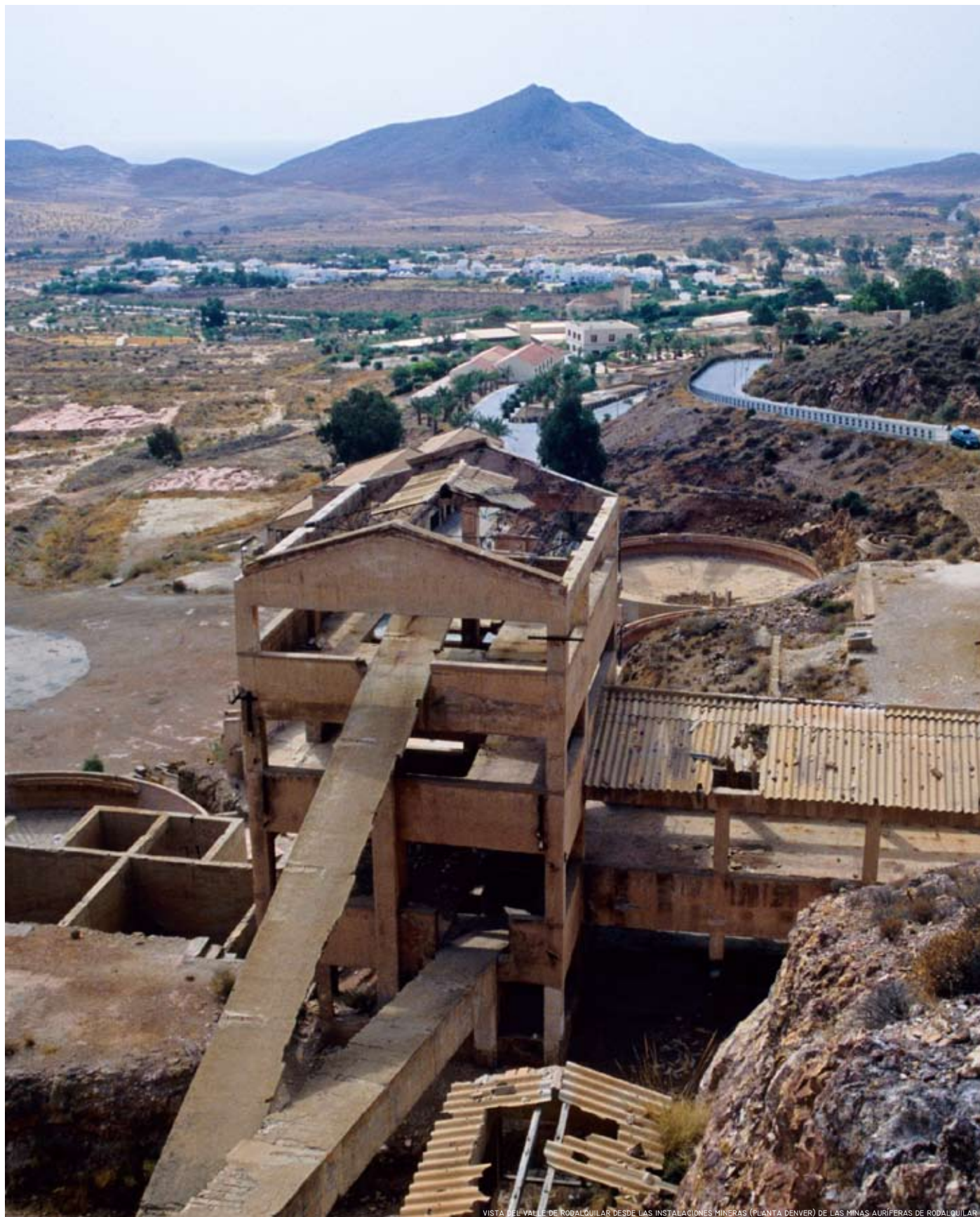
VISTA DEL VALLE DE RODALQUILAR DESDE LAS INSTALACIONES MINERAS (PLANTA DENVER) DE LAS MINAS AURÍFERAS DE RODALQUILAR
