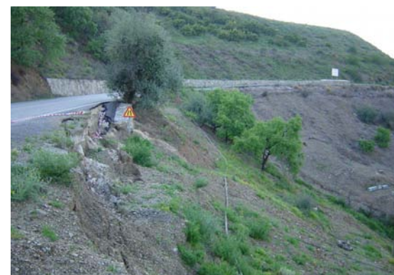
Deslizamiento de carretera. Iznate
