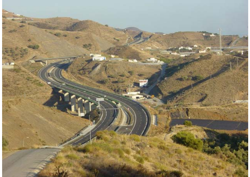
Autovía del Mediterráneo
