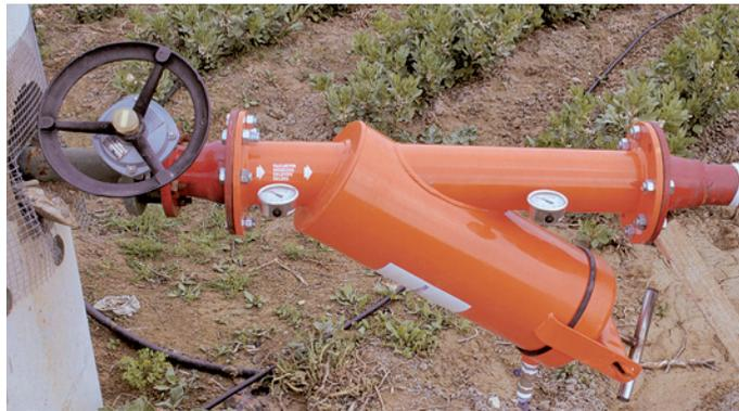
Figura 5. Filtro de malla. Obsérvese la colocación de manómetros a la entrada y salida del filtro para controlar la pérdida de presión.
