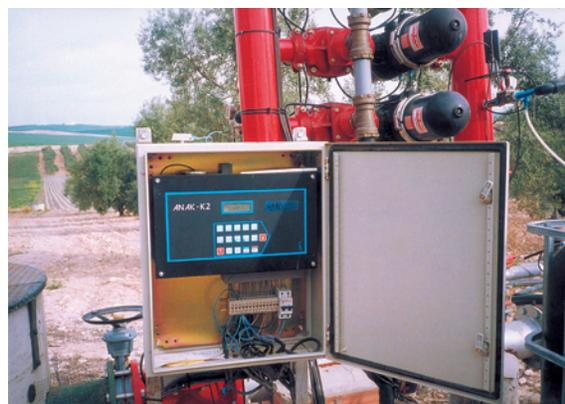
Figura 15. Programador de riego.
