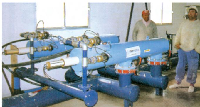
Figura 7. Batería de filtros de malla autolimpiantes.
