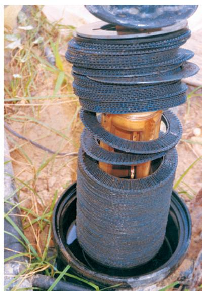
Figura 3. Limpieza de un filtro de anillas.
