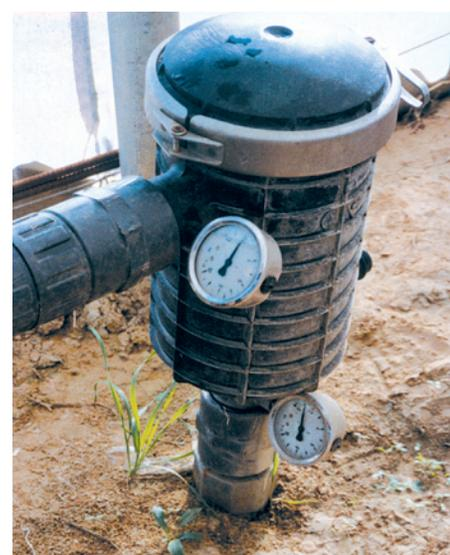
Figura 3. Medida de la presión a la entrada y salida de un filtro de anillas utilizando manómetros.
