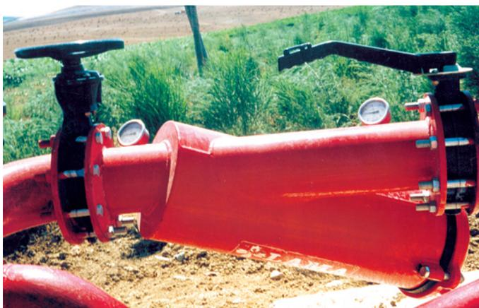
Figura 6. Válvula de compuerta a la izquierda y válvula de mariposa a la derecha de un filtro para el control del caudal.
