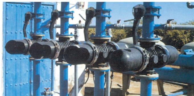
Figura 6. Batería de filtros de anillas.
