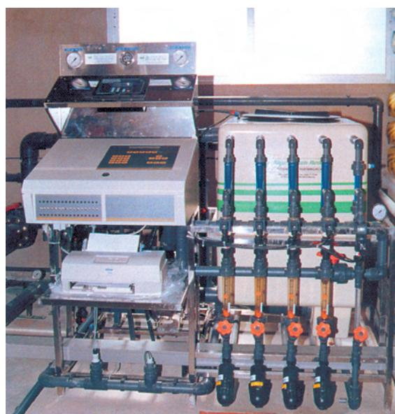
Figura 16. Automatización de la instalación de riego mediante ordenador.
