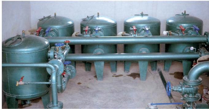
Figura 4. Batería de filtros de arena.
