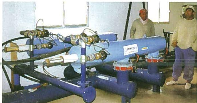
Figura 7. Batería de filtros de malla autolimpiantes.
