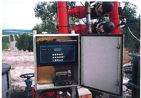
Figura 15. Programador de riego.
