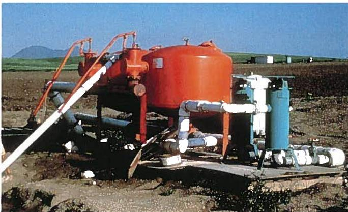
Figura 1. Cabezal de riego localizado.
