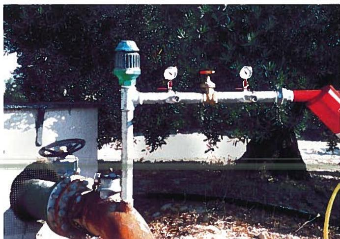
Figura 9. Ventosa bifuncional colocada a la entrada del cabezal de riego.
