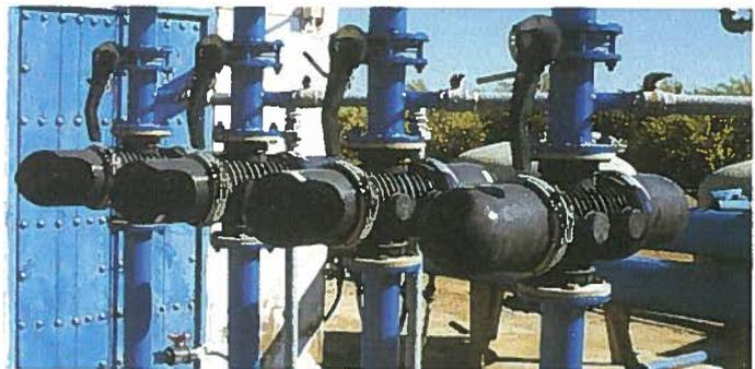
Figura 6. Batería de filtros de anillas.
