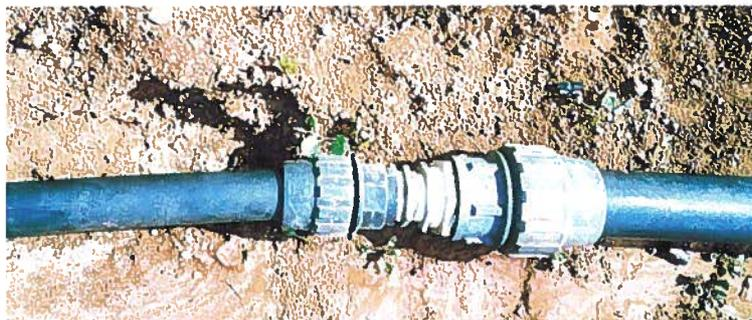
Figura 18. Cambio de diámetro en una tubería de polietileno utilizando racores de unión.
