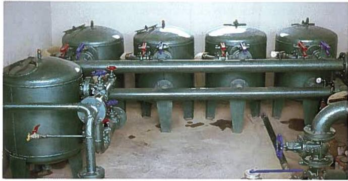
Figura 4. Batería de filtros de arena.
