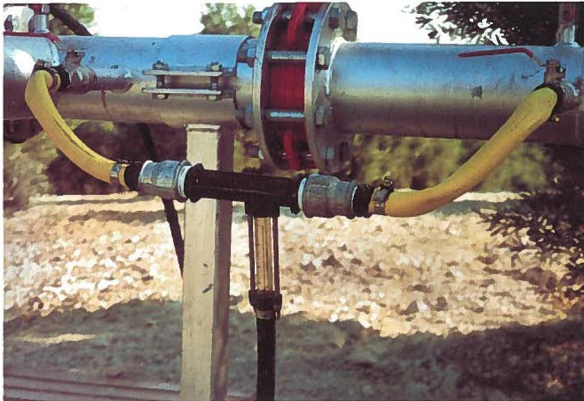
Figura 14. Dispositivo Venturi para inyectar la solución nutritiva al agua de riego.
